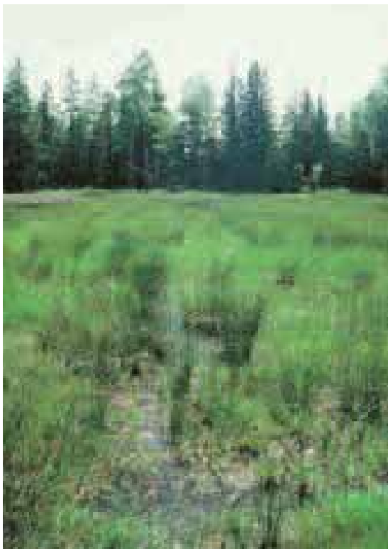
Abbildung 7 Häufig überstaute Bereiche entlang der Sackungsmulden über den unterbrochenen Drainagen
