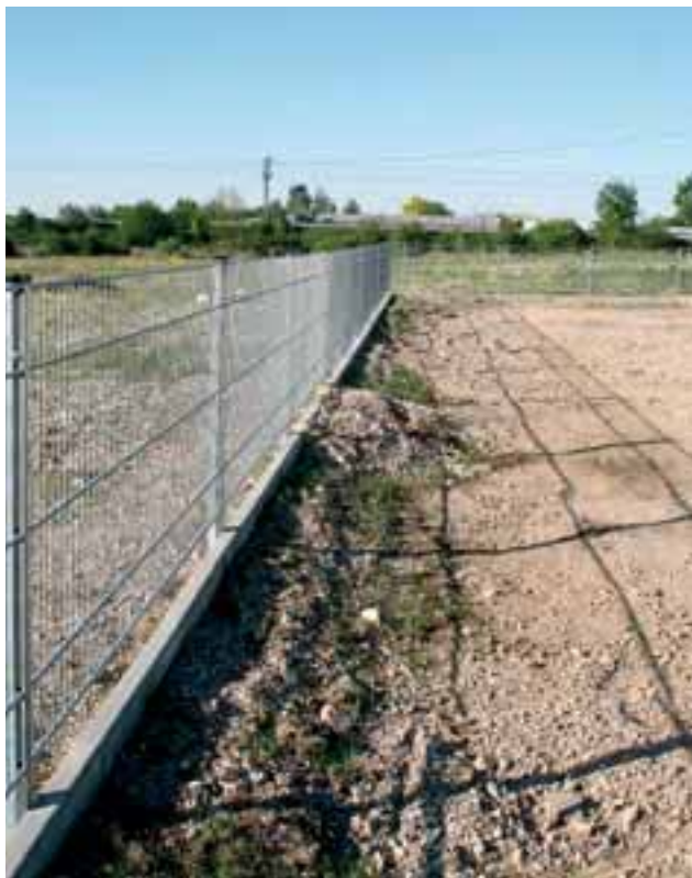
Abbildung 4: Artenschutzoptimierter Bauzaun: Die durchgängige Betonschwelle verhindert, dass Tiere von außen (links im Bild) in den Baustellenbereich vordringen. Von Innen wird die Schwelle aufgeschüttet, so dass Wechselkröten aus dem Baustellenbereich abwandern können. (Foto: Neugebauer)
