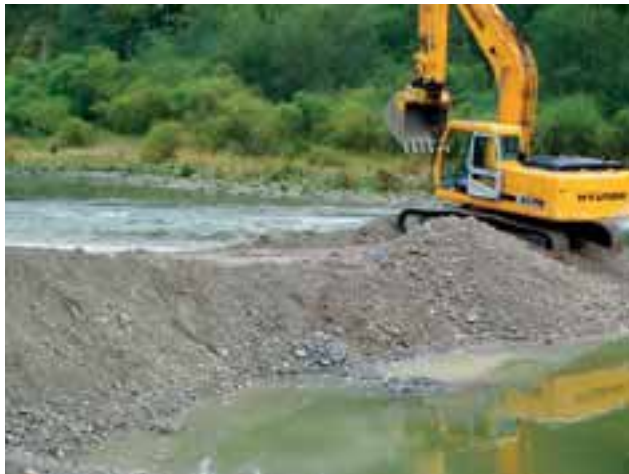
Abbildung 5: Laichplatzrestaurierung per Kieszugabe am Lech, Deutschland (Foto: Pulg 2007)
