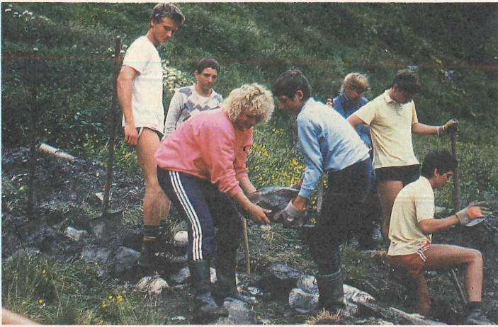
Abbildung 2 Bau einer Sandfilter-Kläranlage (Stickerhütte)
