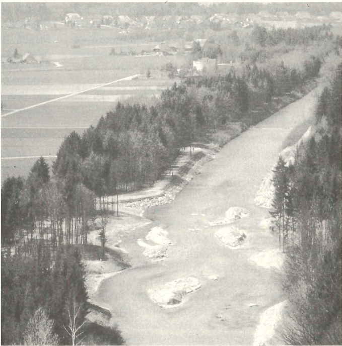
Abbildung 13 Emme (CH), Sohlenstabilisierung durch lokale Gerinnenaufweitung (nach B. ZARN, ETHZ)
