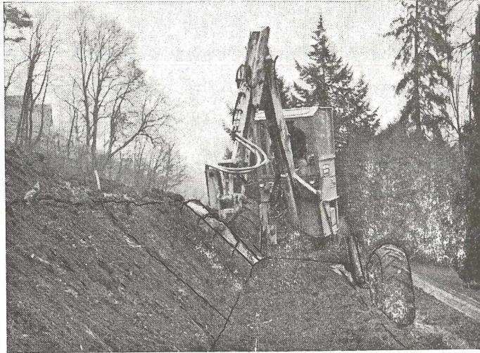
Abb. 13 Hydraulikbagger MENZI-MUCK beim Terrassenbau
