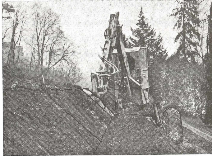
Abb. 13 Hydraulikbagger MENZI-MUCK beim Terrassenbau
