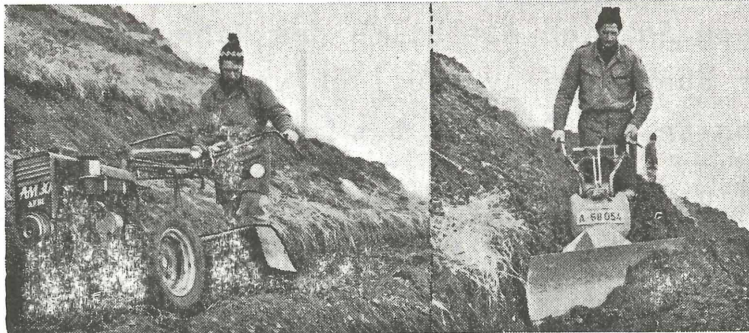
Abb.11 Lockern und grobes Ausplanieren mit Motorfräse
