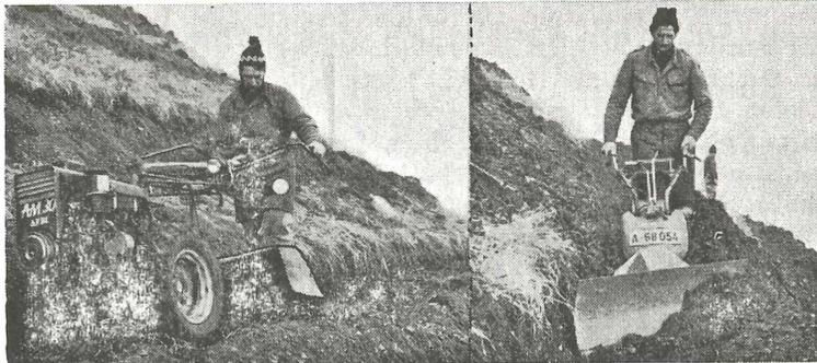
Abb.11 Lockern und grobes Ausplanieren mit Motorfräse
