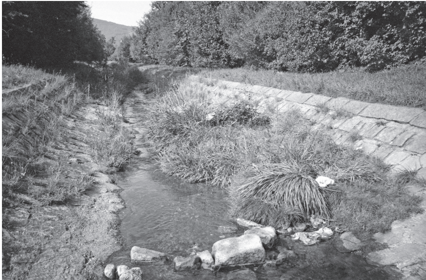
Abbildung 3: Der Höllmühlbach war im gesamten untersuchten Bereich reguliert und enthält kaum feines bzw. loses Sohsubstrat. Linz, Österreich (10.08.2000). – Figure 3. The 'Höllmühlbach' was regulated in the investigated section and fine sediments were only found at very few spots in the river bed. Linz, Austria (10-viii-2000).
