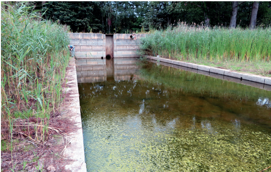
Abbildung 1: Abfischbecken 2 im Niederspreer Teichgebiet, 10.08.2019. – Figure 1. Concrete tank 2 in the Pond Area of Niederspre, 10-viii-2019. Photo: TB
