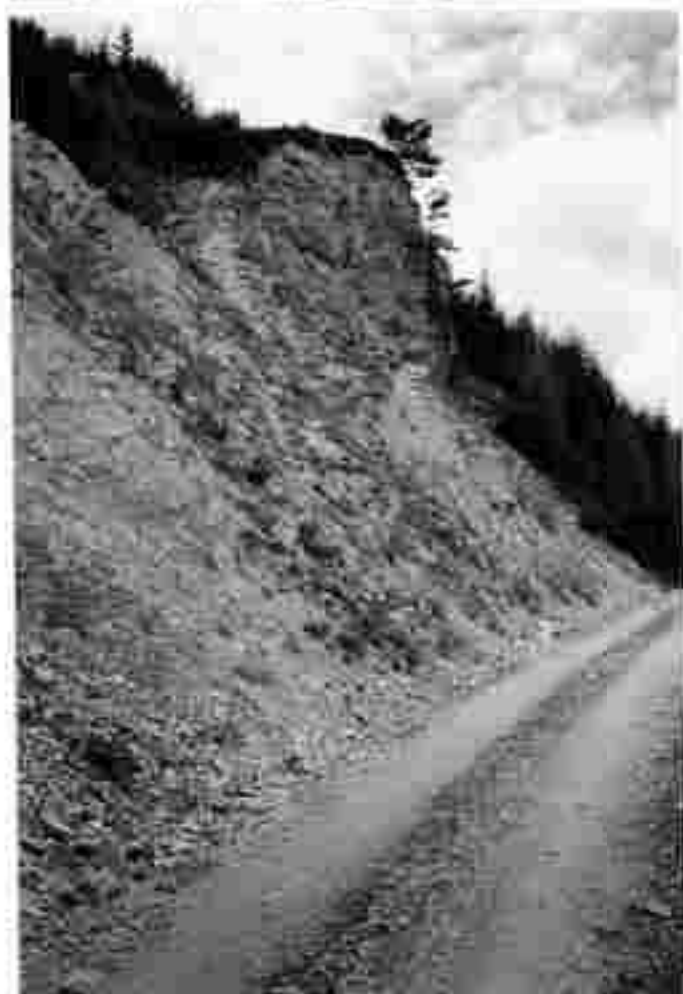
Abb.8: Flitzenschlucht W-Seite, Güterweg 1190 m. Flachliegender Quarzit, plattiges - kleinstückiges Bruchver- halten. Einlagerungen schieferiger Lagen sind möglich.
