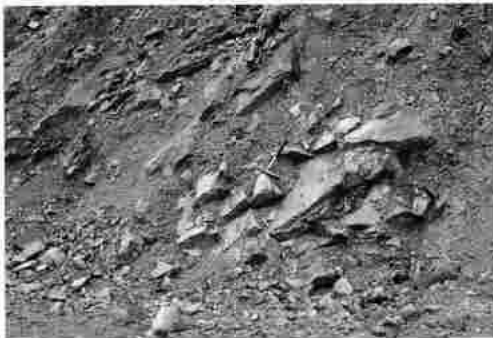
Abb.17: Lössengraben süd. St.Georgen ob Murau, neuer Forstweg auf den Birklintonkogel 1210 m. Dickbankiger Quarzit mit häufigen Limonitbestegen auf den Klüften.
