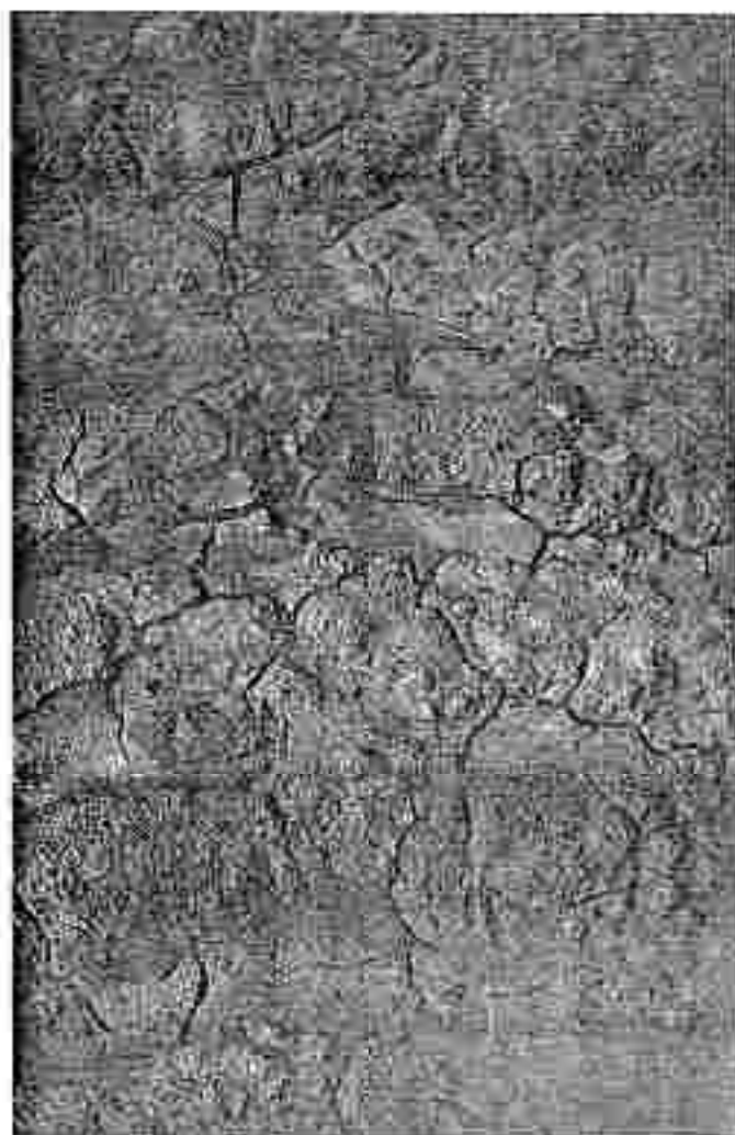
Abh.6: Oberfläche der Kippe: Etwa 4 Stunden nach Aufhören des Regens ist die Oberfläche von Trockenrissen durchzogen. Aufnahmezeitpunkt: Juni 1989
