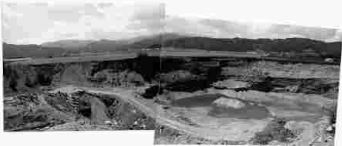
Abb.19: Fohnsdorf, Hetzendorf; Kiesgrube im Aichfeld; Abbau bis an die Grundwasseroberkante, Bauschuttauffüllung
