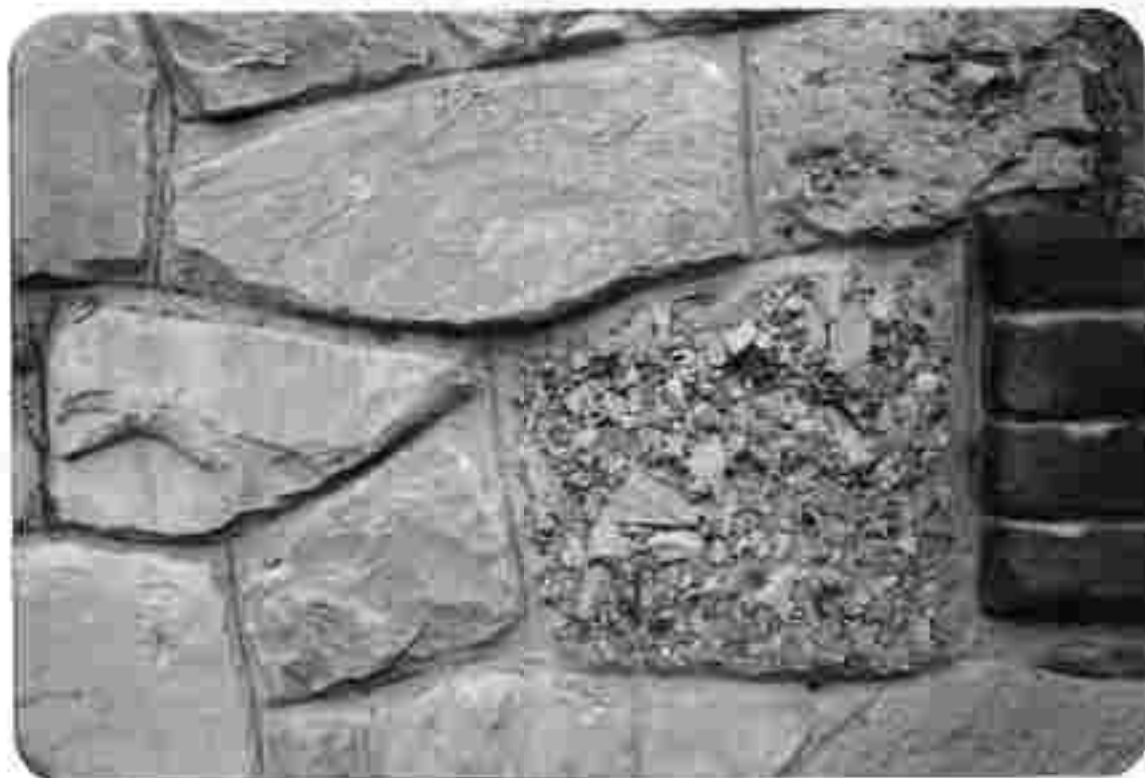
Abb. 4: Detail aus dem Mauerwerk des Kraftwerk-Betriebsgebäudes NNW Bahnhof Vordernberg mit eingebautem Konglomerat/Breccien-Block.
