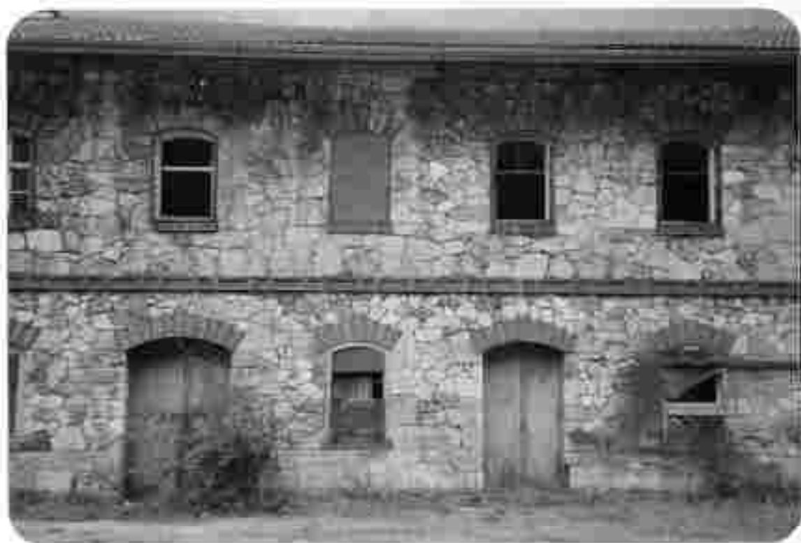
Abb. 3: Altes Kraftwerk-Betriebsgebäude NNW Bahnhof Vordernberg, bei dem neben Kalksteinen auch quartäre Konglomerate/Breccien als Baustein Verwendung fanden.
