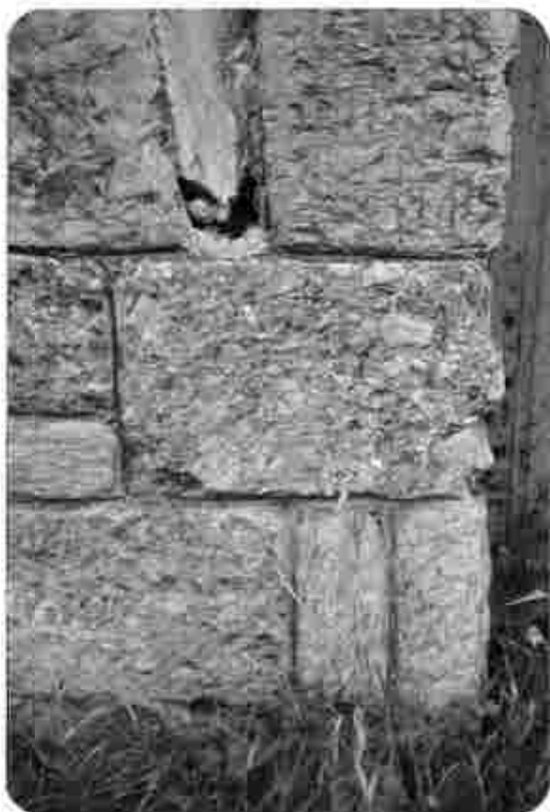
Abb. 6: Kraftwerks-Betriebsgelände, NNW Bahnhof Vorderberg: Eingebaute Konglomerat/Brekzien-Bausteine zeigen a) gute Formatisierbarkeit und b) große Verwitterungsresistenz.
