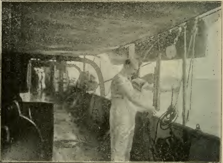
Abb. 3. Die elektrische Tiefseewinde (nach Aufnahme von Dr. Pietschmann). Ein Beobachter verfolgt ein in die Tiefe gehendes Fallgewicht, während der zweite Wasser aus einem Ekmanschöpfer abläßt. Im Hintergrund bei der Kommandobrücke die Lucaslotmaschine.
