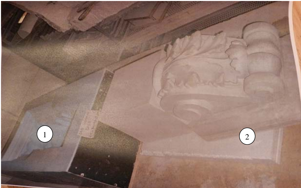
Abb. 3: Herstellung einer Zierkonsole. In die Form (1) wird die Betonmasse eingefüllt und von Hand angepresst. Danach wird die erhärtete Konsole herausgelöst (2)
