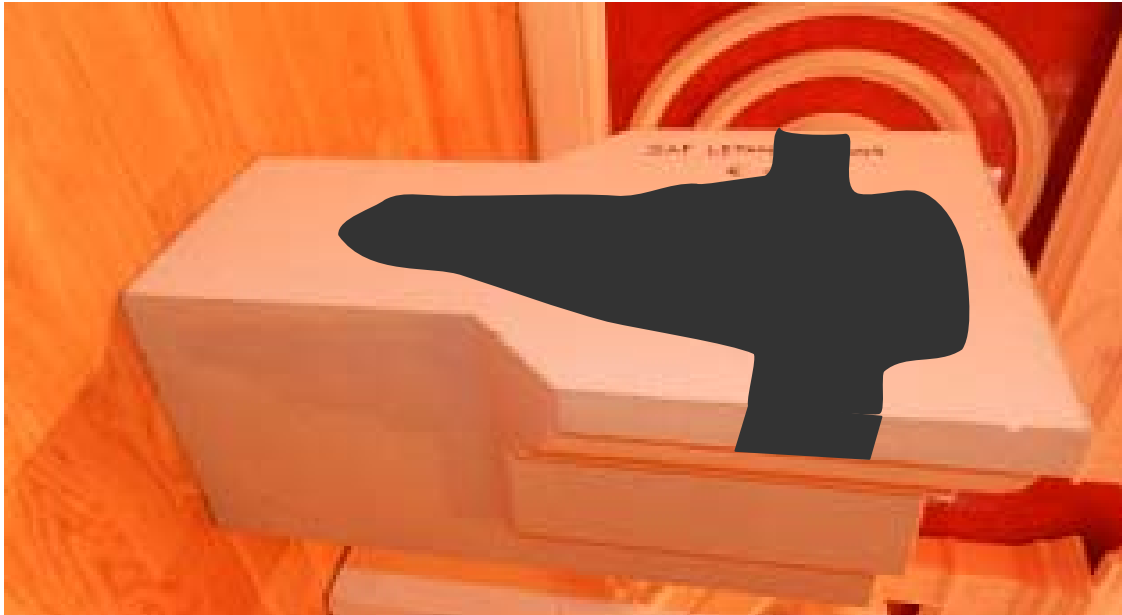
Abb. 8: Hohlraum und Öffnungen, die in eine Styropor-Zierkonsole geschnitten werden müssen, um einen geeigneten Mauersegler-Nistplatz anbieten zu können.
