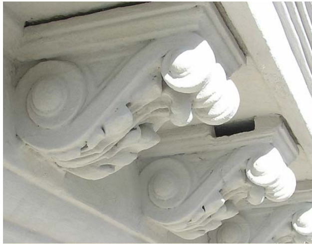
Abb. 11 Seitlich geöffnete Zierkonsole. Beispiel Kriehubergasse
