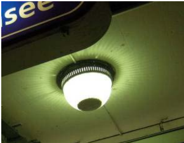
Abb. 19: Leuchte mit tausenden toten Insekten Die Leuchte wurde inzwischen durch Abdeckung der Schlitze entschärft. Foto: Clemens Purtscher
