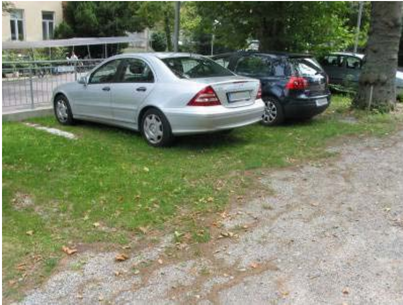
Abb. 22: Schotterrasen-Parkplatz an der Universität für Bodenkultur Foto: Bernhard Scharf
