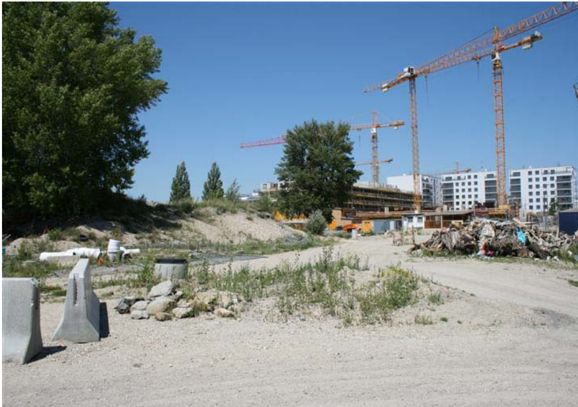
Abb. 8: Bautätigkeit am Nordbahnhofgelände.
