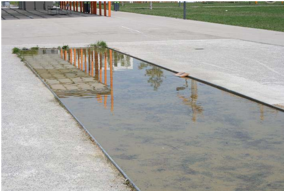
Abb. 6: Rudolf-Bednar-Park, Wasserbecken mit nur einer kleinen Ausstiegshilfe und umliegender Asphaltfläche
