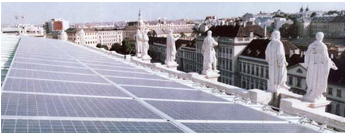
Abb. 4.2: Photovoltaikelemente auf dem Dach des Kunsthistorischen Museums (siehe auch Farbtafel „Grünflächenveränderungen in Wien: Baumpflanzungen“ Luftbild 1997 oben)
