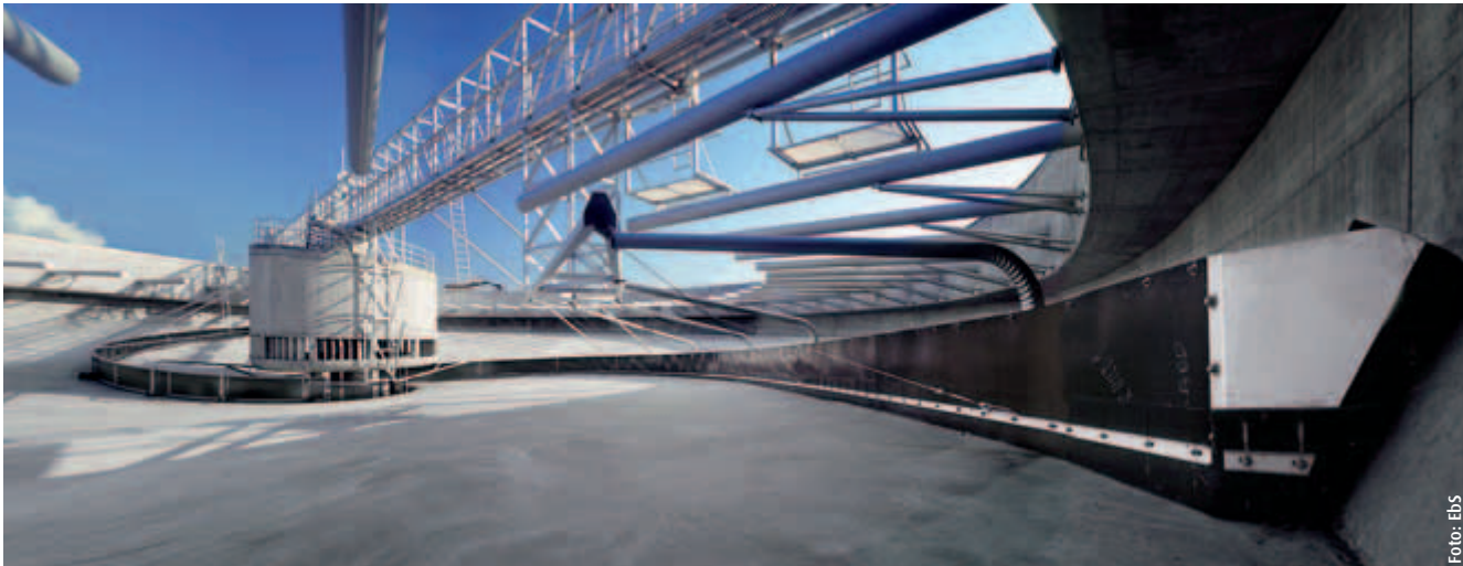
Blick auf den „Nachklärbecken-räume“ in einem der 15 neuen gewaltigen Nachklärbecken in der erweiterten Hauptkläranlage Wien
