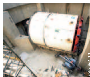
Einbau des Fräskopfs des Wiener „Bohrwurms“ im rund 30 m tiefen Startschacht
