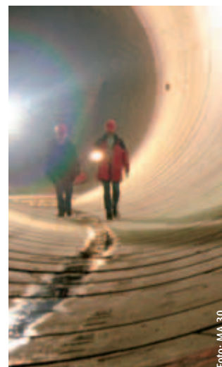
Fertig gestellte Tunnelröhre des neu errichteten Wiental Kanals
