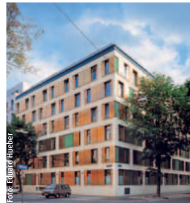
Das im August 2005 fertig gestellte Studentenwohnheim (Molkereistraße) in Passivhausbauweise
