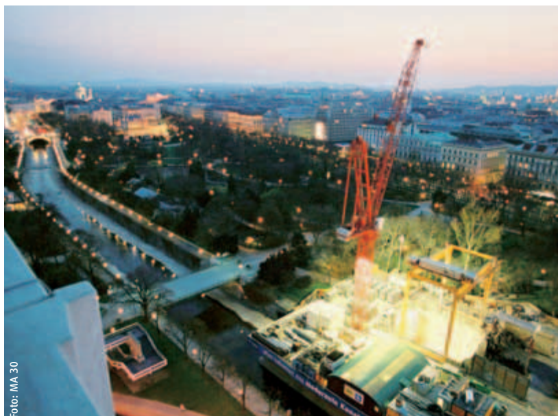
Wienfluss im Bereich Stadtpark mit Startschacht des Wiental Kanals
