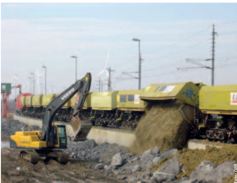
Unter Einbindung der ÖBB kam es 2005 zu einem Projekt, das ganz den Zielsetzungen von „RUMBA“ entsprach. So erfolgte die Entsorgung von Aushubmaterial ausschließlich per Bahn!
