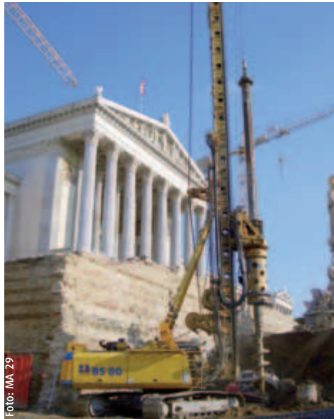
Große Baustellen (wie hier beim Parlament) sorgen bei der Bevölkerung oft für mulmige Gefühle in der Magengegend – vor allem dann, wenn auch noch Fensterscheiben und Einrichtungsgegenstände erzittern
