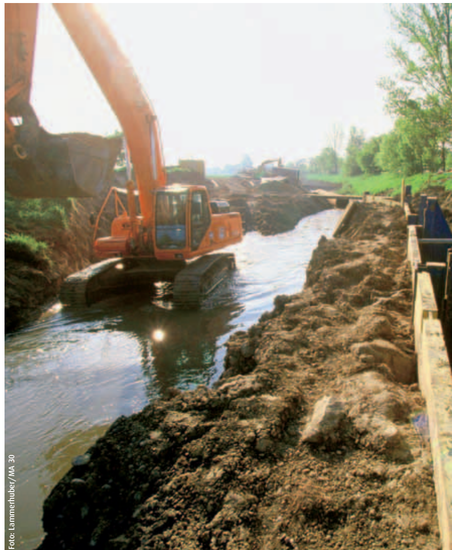
Baggerarbeiten am Liesingtal Kanal
