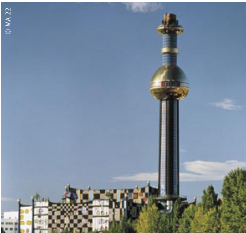
Müllverbrennungs- anlage Spittelau
