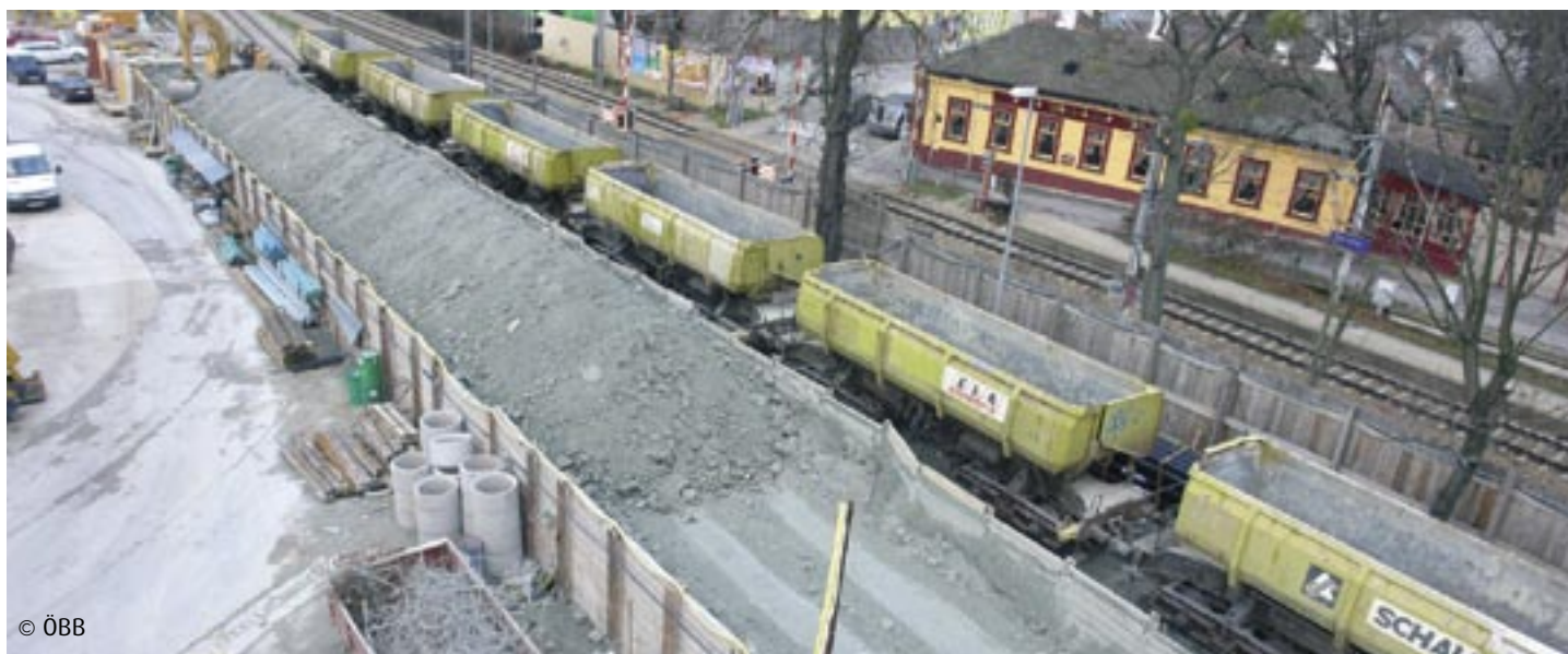
Bahntransport – Wien 13, Lainzer Tunnel LT 31 – Preyergasse
