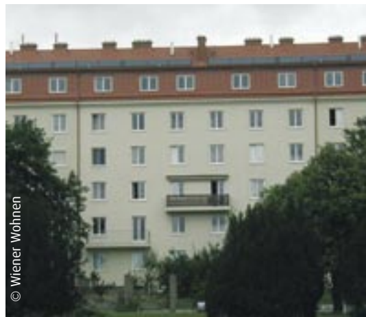
Wohnhausanlage Hugo Breitner Hof
