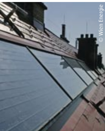
Bei der Generalsanierung des Hugo-Breitner-Hofes im 14. Bezirk wurde neuer Wohnraum geschaffen und umweltfreundliche Energienutzung errichtet.
