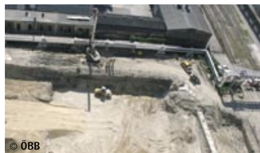
Wienenergie – Wien 11, Repowering KW Simmering Herstellung Bohrpfähle
