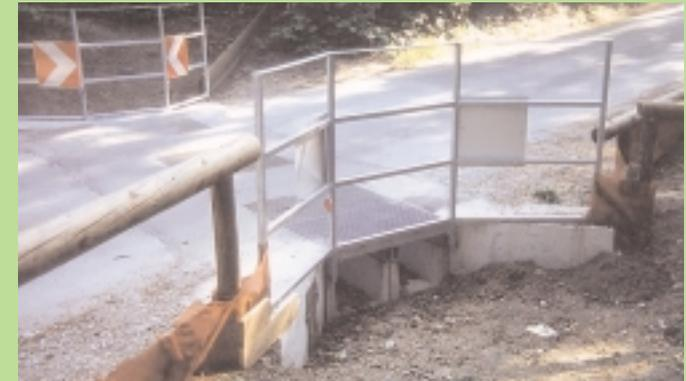
Zum Schutz der Kröten lässt die Wiener Umweltschutzabteilung auch kleine Tunnelröhren bauen. So im Rosental im 14. Bezirk. Der Tunnel besteht aus zwei Laufröhren, die mit Betonplatten und Schachtgitter abgedeckt sind. Nun können die Amphibien durch den Tunnel bis zur gegenüberliegenden Straßenseite hüpfen. Einen zweiten Tunnel gibt es im Prater beim Lusthaus. Dort wurde eine steinerne Wasserrinne, die unterhalb der Rennbahnstraße verläuft, als Tunnel adaptiert.
