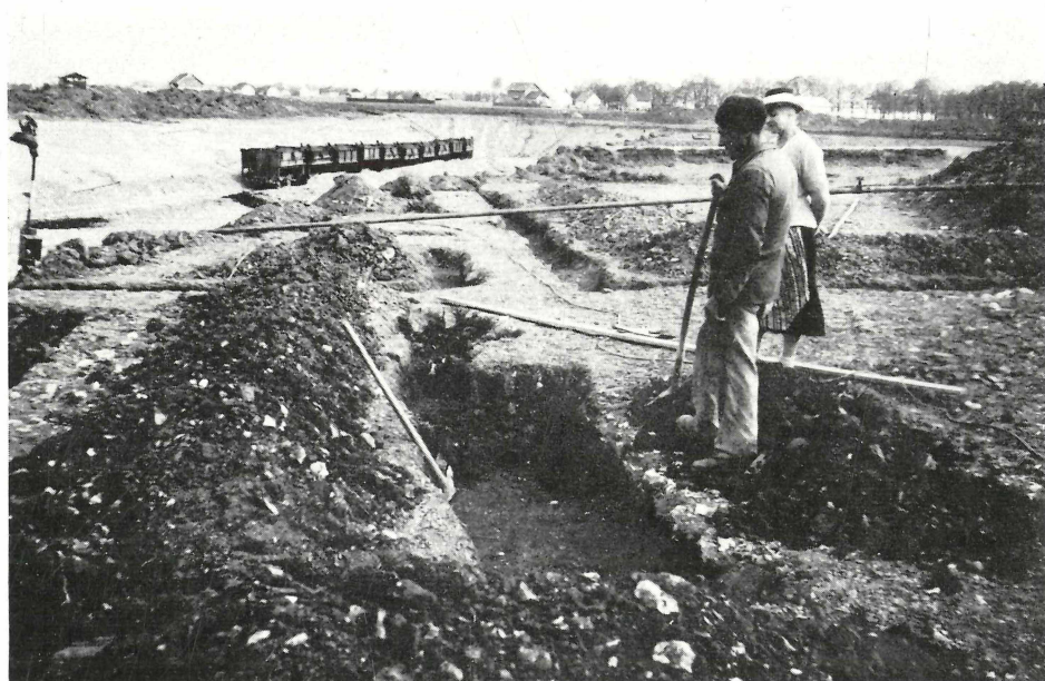
Abb. 9 2: Grabung im Objekt II. Im Hintergrund Maxglan
