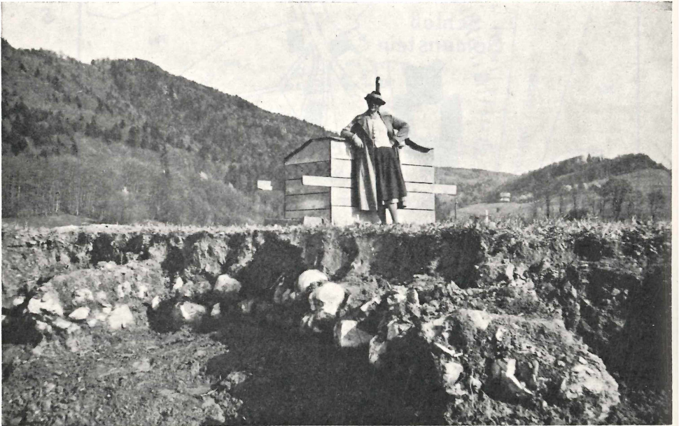
Abb. 2b Blick gegen Südost. Mauerecke des Bauteiles II wurde aufgedeckt.
