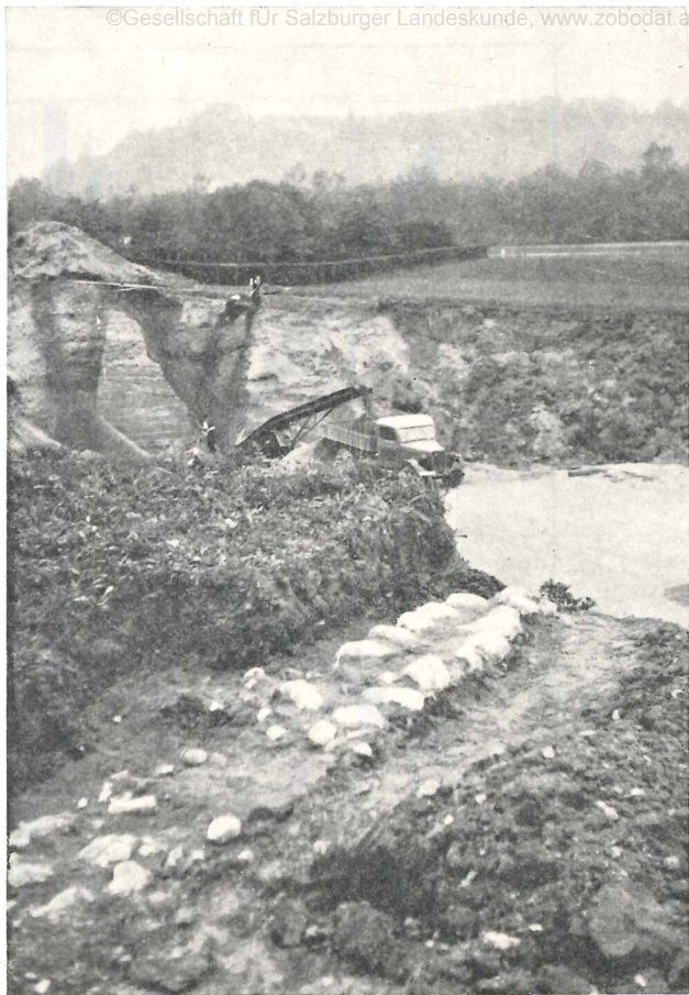
Abb. 3b Diesel Mauer des Bauteiles II. Dahinter der Hellbrunnerberg.
