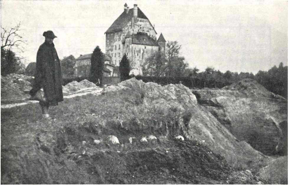
Abb. 2a Elsbethen. Blick gegen Süden. Die römische Mauer, Bauteil I, kommt zum Vorschein. Rechts die Schottergrube, Mitte Schloß Goldenstein.
