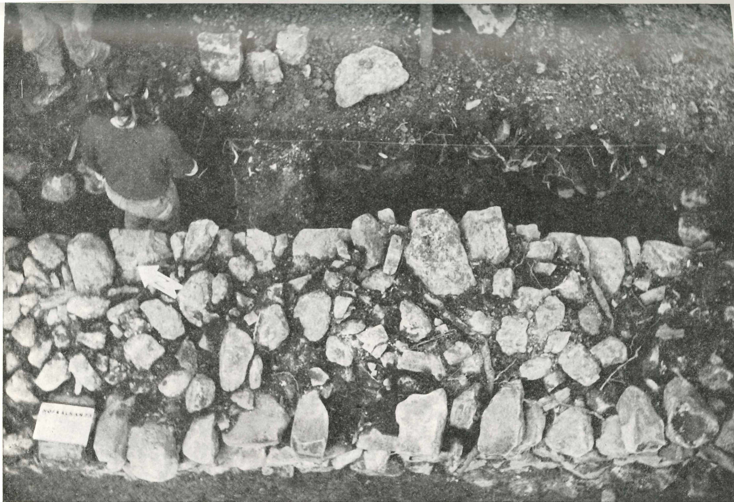
Abb. 1 Blick auf einen freigelegten Abschnitt der Ringmauer von Burg Kalham (Aufnahme: Eberherr)
