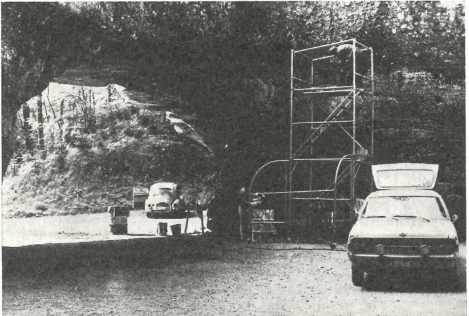
Abb. 8 Unterstützungsbogen und Dach des Eingangsbogens während der Sanierung
