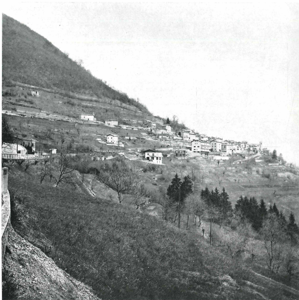
Abb. 2 Ansicht von Verna, der Heimat Santino Solaris
