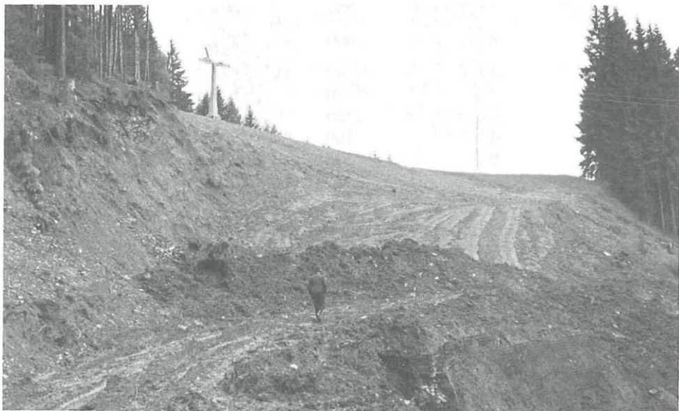
Abb. 33 Murenabbruch im Raume „Pfaffenbach“ nach Verbreiterungsarbeiten an der Nordabfahrt. Im Hintergrund Stütze der Zeller Bergbahn. (Aufn. H. Hinterstoisser)
