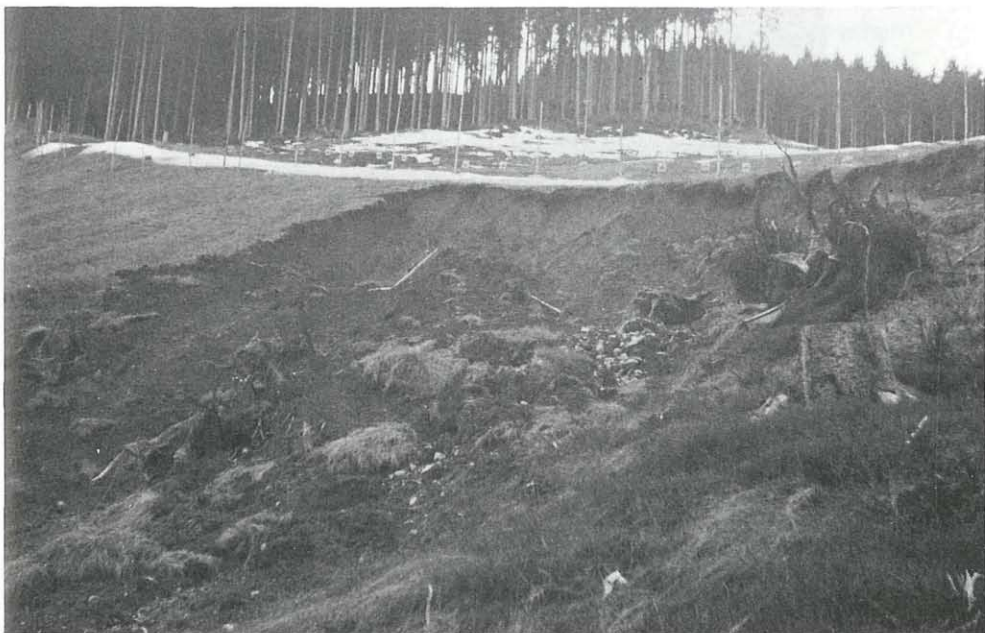
Abb. 42 Abbruch der talseitigen Böschung der Standardabfahrt im „Großen S“ 1979. (Aufn. H. Hinterstoisser)
