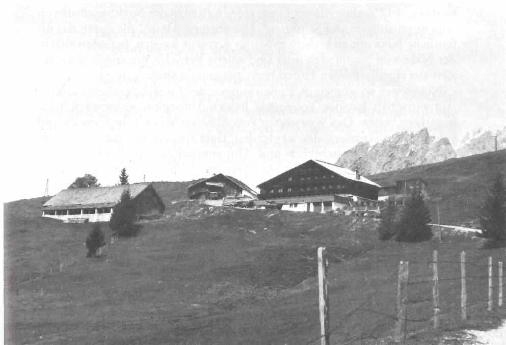
Abb. 12 Die Koppalm (Bildmitte) mit dem Alpengasthaus „Kopp Hütte“ und dem gemeinschaftlichen Jungviehscherm (links im Bild) im unteren Teil der Wiedersbergalm. Im Hintergrund ist der südliche Ausläufer des Hochkönigs mit der Taghaube (2159 m) zu sehen. Aufnahmedatum: 3. Juni 1984.
