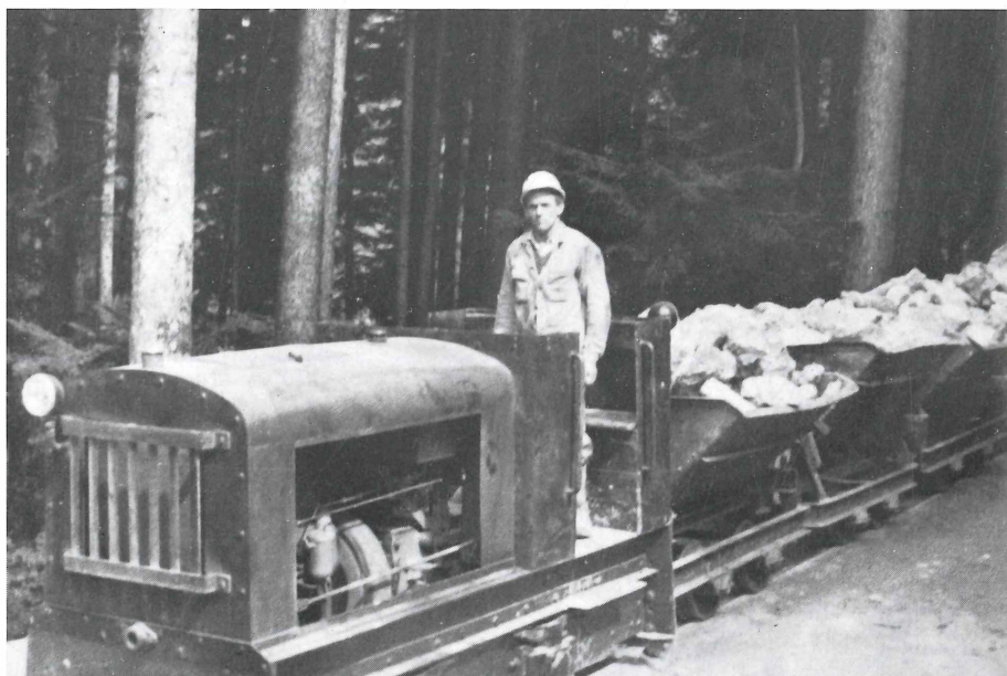
Abb. 118 Gipsbergbau Hallberg/Abtenau (Gustav Haagen). Förderung des Rohgipses mittels Feldbahn zur Brecheranlage. (Haagen)
