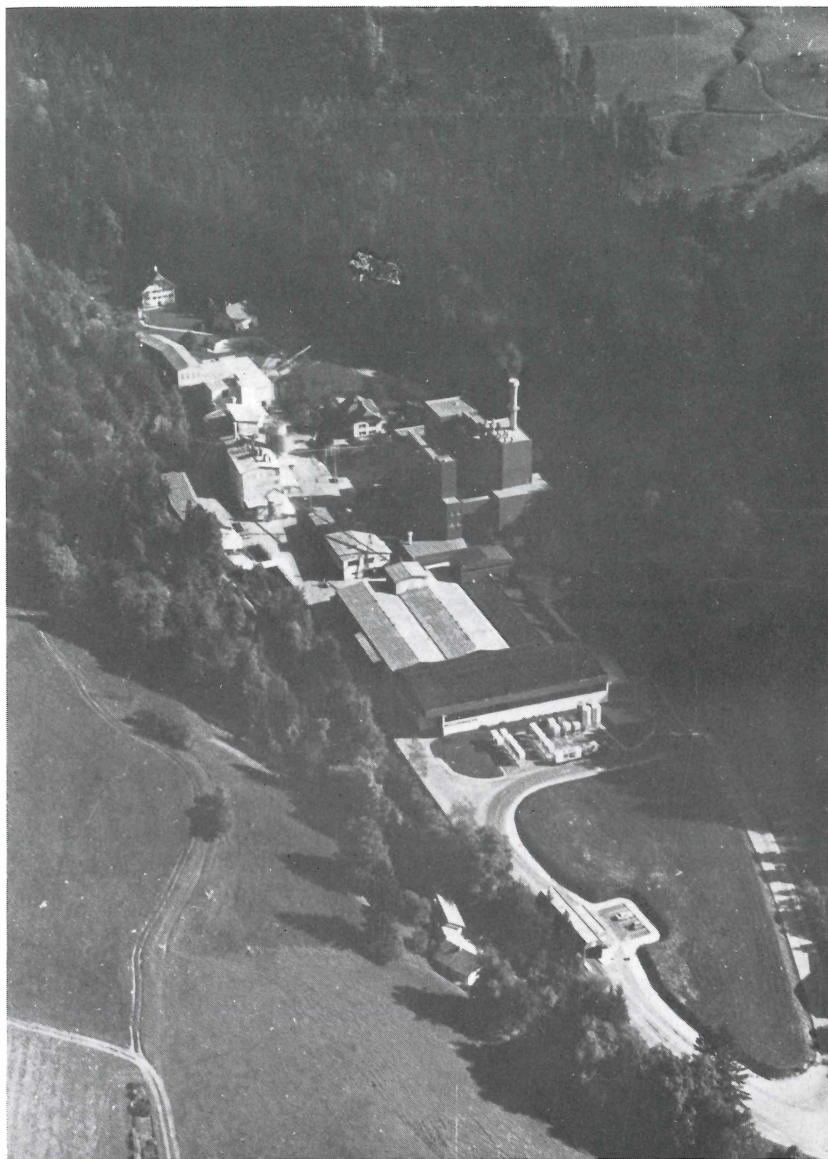
Abb. 92 Gipswerk Grabenmühle. Gesamtansicht, im Hintergrund „Grabenmühle“, Bildmitte Gipskocheranlage mit Maschinenputzgipsanlagen „Danburg“ und „Mühlburg“, Vordergrund Gipsplattenwerk und automatische Wiegeanlage, Sommer 1984. (Moldan)
