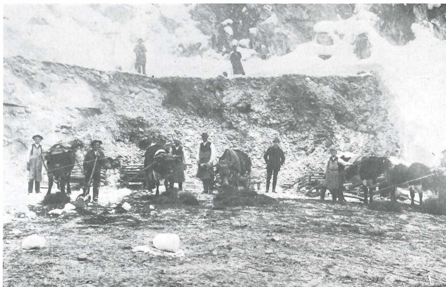
Abb. 19 Gipsbruch am Moosegg, um 1880. Abtransport der Gipssteine mittels „Gipsschlarpfen“. (Moldan)
