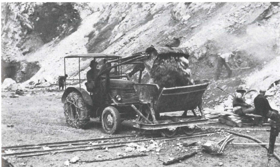
Abb. 105 Einsatz eines „Steyr“-Traktors mit Baggerschaufel, 1957. (Moldan)
