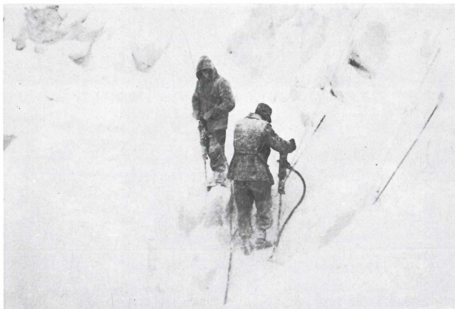
Abb. 97 Gipssteinbruch Moosegg. Bohrarbeit mittels Preßluftschlämmern, Winter 1949/50. (Moldan)
