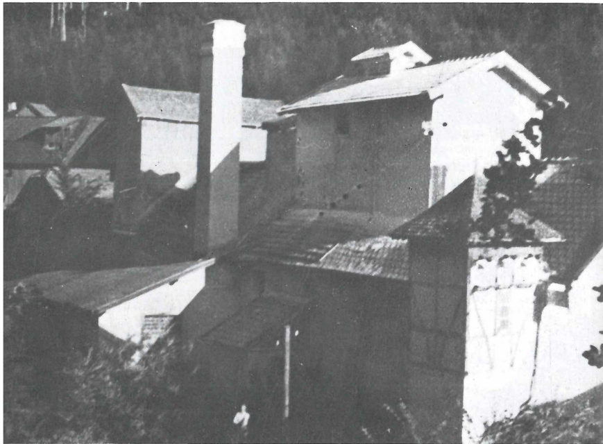
Abb. 42 Gipswerk Grabenmühle vom Kertererbach aus gesehen. Rechts im Vordergrund das Transformatorenhaus, links im Hintergrund ein Holzanbau für Antriebsmotor. Bildmitte Hauptgebäude der Brennerei. (Moldan)
