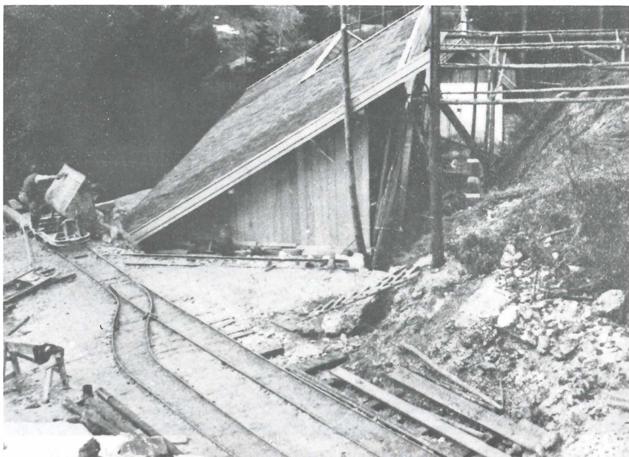
Abb. 37 Bergstationsgebäude der Materialseilbahn nach erfolgtem Umbau, 1950. (Moldan)
