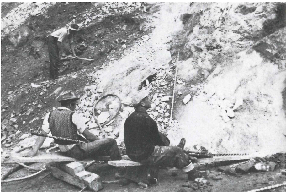
Abb. 103 Bohrarbeit mittels Preßluftbohrer, 1957. (Moldan)
