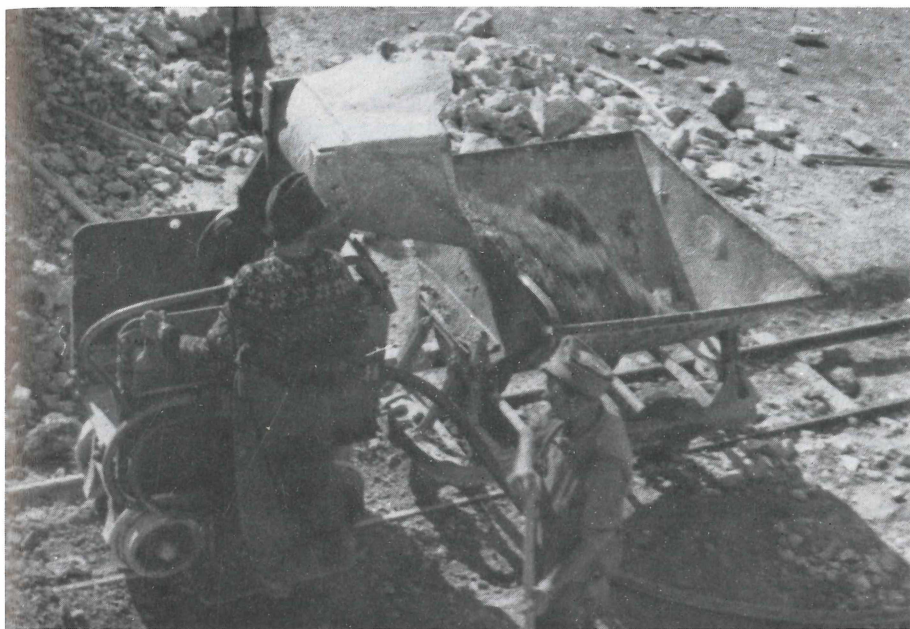
Abb. 104 Gipssteinbruch Moosegg. Einsatz eines „Überkopfladers“, 1950. (Moldan)
