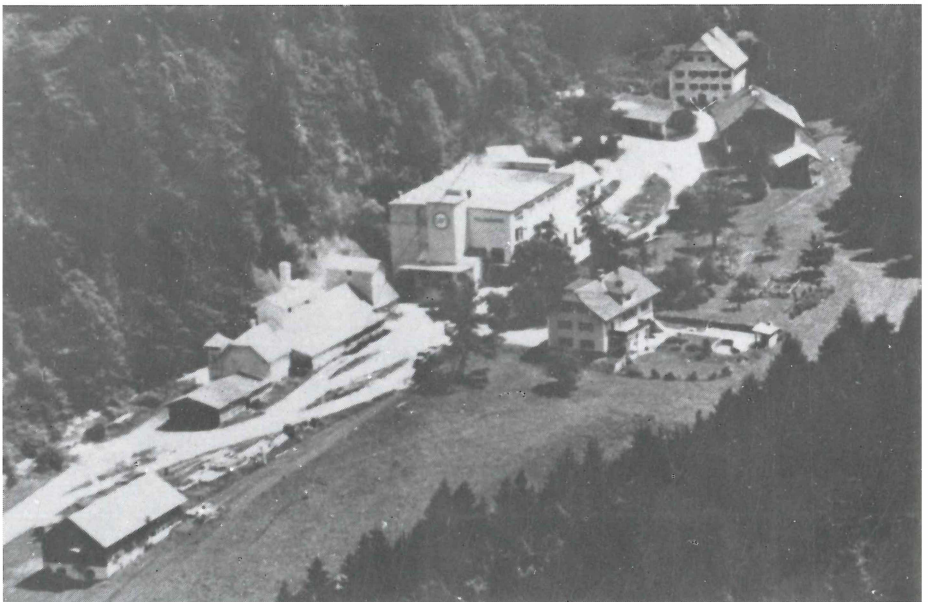
Abb. 54 Gipswerk Grabenmühle. Links im Vordergrund altes Brennereigebäude, Bildmitte neu errichtete Siloanlage mit Hochleistungskochern, im Hintergrund die „Grabenmühle“, 1959. (Moldan)
