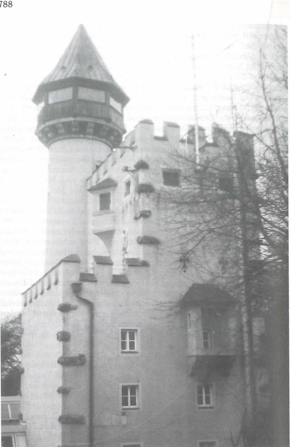
Abb. 4 Aussichtsturm auf dem Mönchsberg beim Café Winkler. Der oberste Teil des zinnenbekrönten Bauwerks war Wasserreservoir, der breitere Bau-
