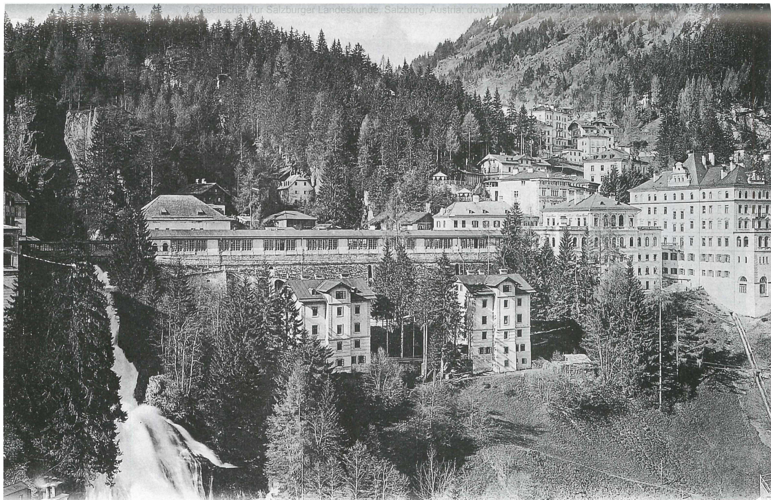
Abb. 7 Bad Gastein im Jahr 1898 mit dem 1886–1888 erbauten Hotel Weismayr (ganz rechts) und dem 1888/89 errichteten Kurkasino (daneben).
