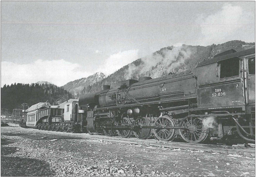
Abb. 5 Die ÖBB-Lok 52.836 schiebt den Tiefladewagen 590500 mit einem Trafo auf Gleis 1b in die Freiluftschaltanlage (19. Mai 1951) (Werkfoto der Tauernkraftwerke AG, Nr. 268).
