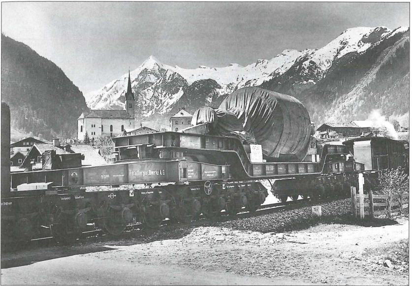
Abb. 4 Transport eines Läufers mit dem Tiefladewagen der Vorarlberger Illwerke AG Nr. 590500 an der Kreuzung mit der neuen Kapruner Landesstraße bei km 5,087 (19. Mai 1951) (Werkfoto der Tauernkraftwerke AG, Nr. 268).
