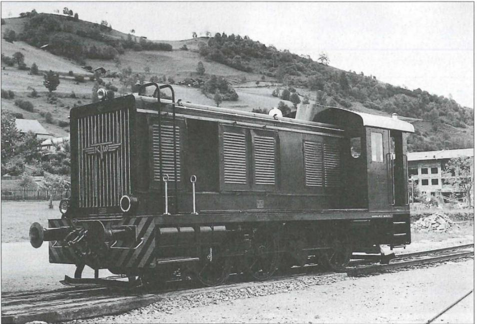
Abb. 9 Die Lok 2065.11 in Kaprun. Das Dreilichtspitzensignal erhielten die beiden Loks schon im Herbst 1961, also noch vor den ÖBB-Loks, da die Anschlussbahn drei kritische Straßenkreuzungen mit starkem Verkehr besaß (6. Juli 1968) (Werkfoto der Tauernkraftwerke AG, Nr. 84/14).
