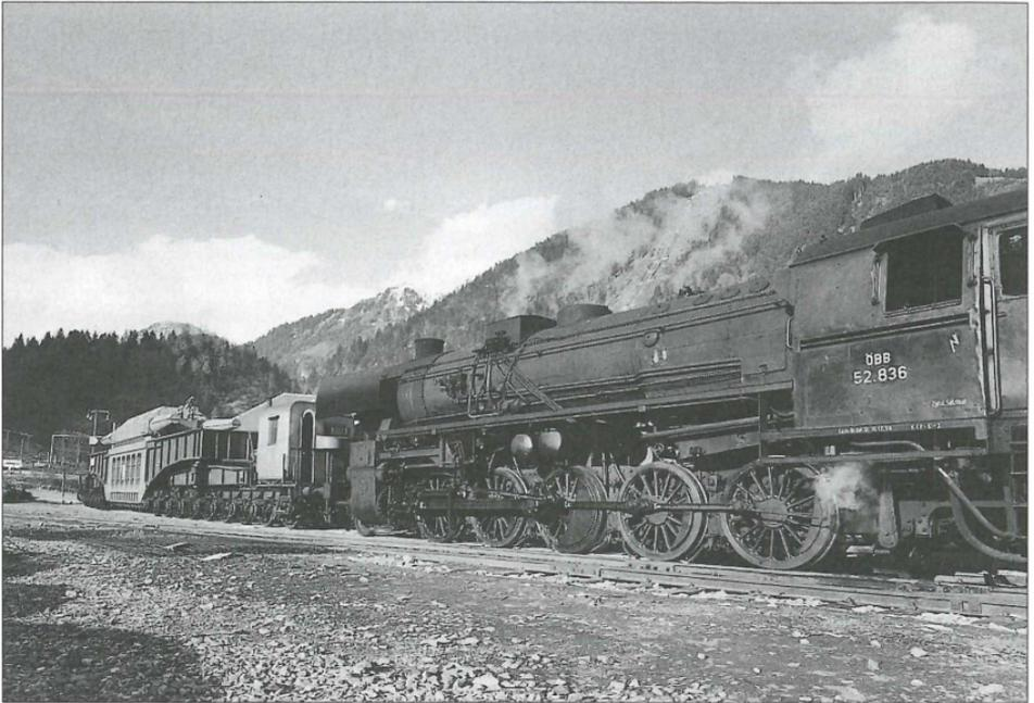
Abb. 5 Die ÖBB-Lok 52.836 schiebt den Tiefladewagen 590500 mit einem Trafo auf Gleis 1b in die Freiluftschaltanlage (19. Mai 1951) (Werkfoto der Tauernkraftwerke AG, Nr. 268).
