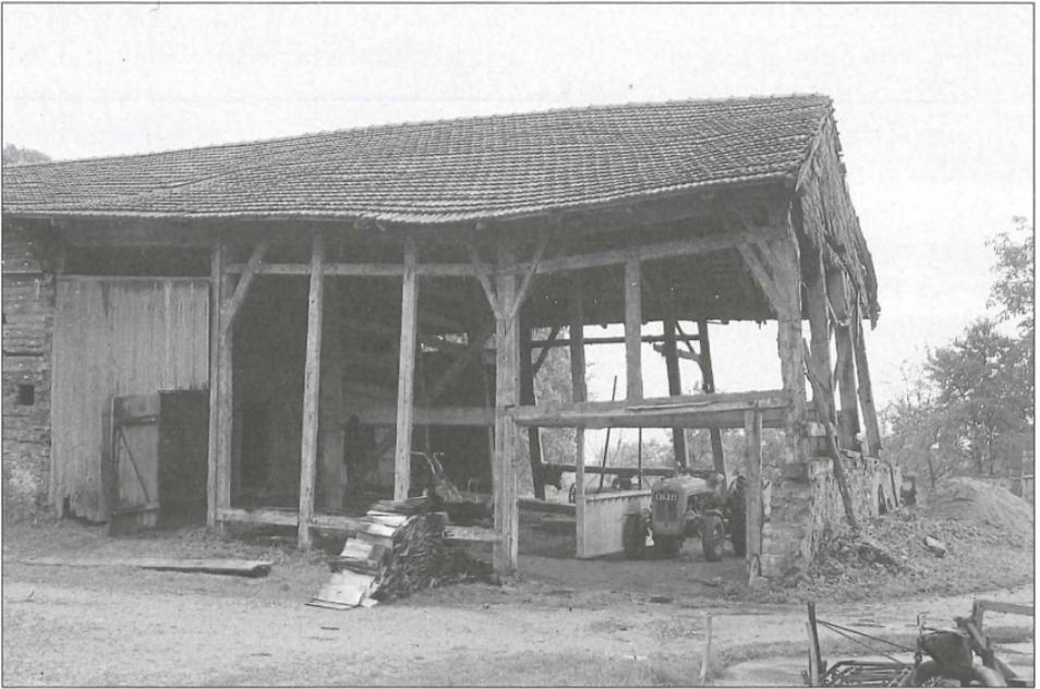
Bei der Abtragung sieht man deutlich den Ständerbau des Stallteiles
