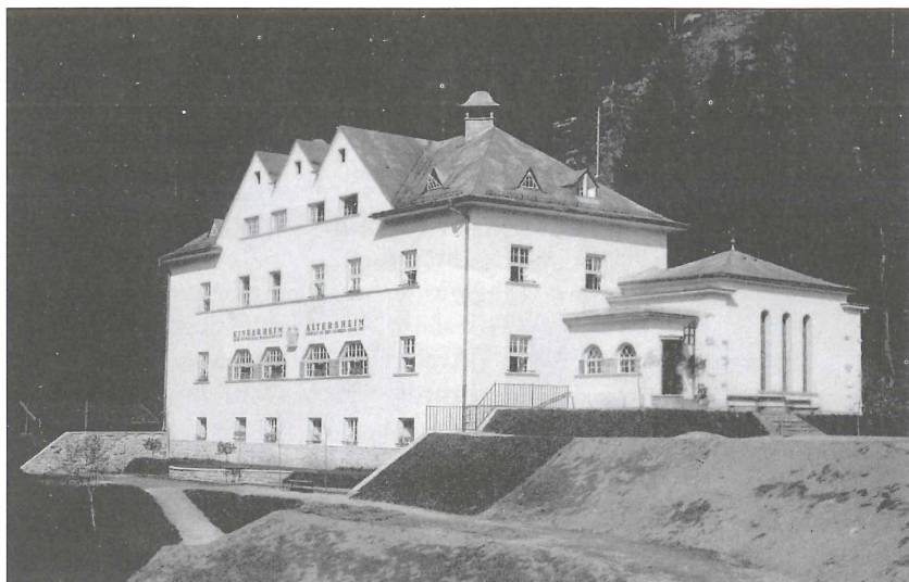
Abb. 19 Das Alters- und Kinderheim wurde 1926/27 nach den Plänen von Walz erbaut. Im Sommer 2004 wurde es komplett abgetragen (Foto: Wolkersdorfer/Archiv DI Paul Franzmair).
