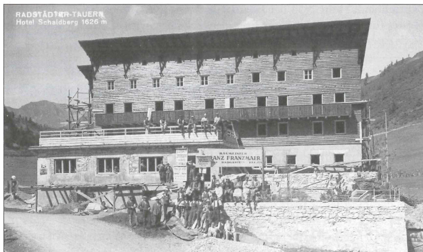
Abb. 21 Nach einem Brand errichtete die Firma Franzmair 1933 nach den Plänen des mittlerweile selbstständigen Architekten S. Karl Huber das neue Hotel Schaidberg am Radstädter Tauern (Foto: Ehringer, Radstadt, Archiv DI Paul Franzmair).
