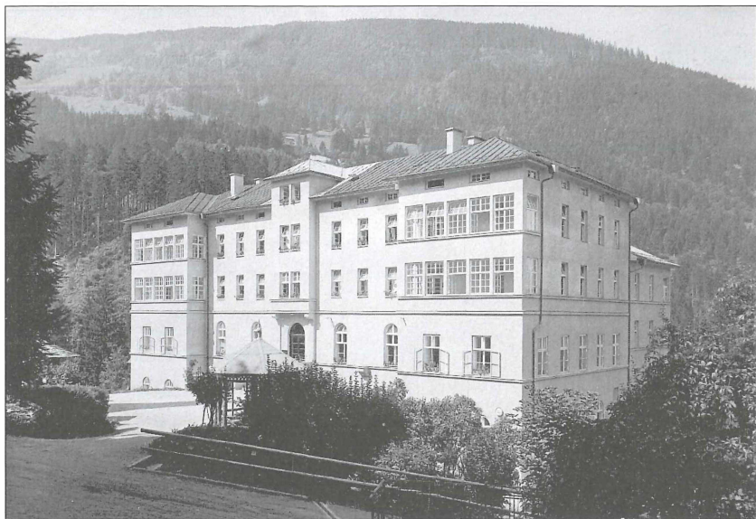
Abb. 14 Das Badehospiz in Bad Gastein (um 1931) wurde nach Gepperts Plänen umgebaut (Foto: Fürböck, Linz/Archiv Gasteiner Museum).
