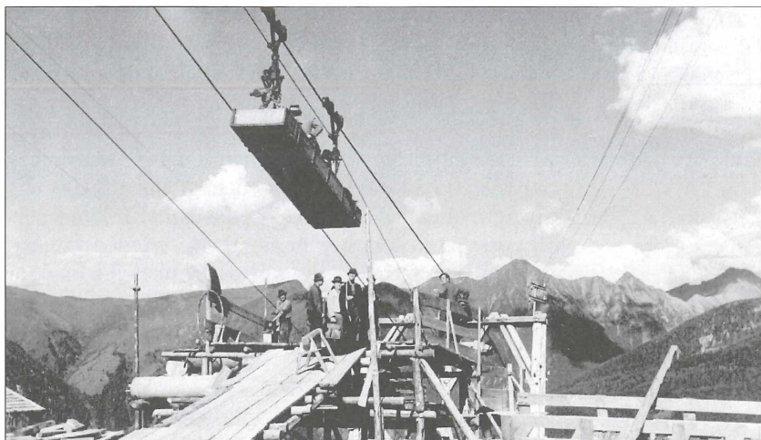
Abb. 24 Die Materialeilbahn für den Bau der Stubnerkogelbahn 1949/50 diente auch als Transportmittel für die einheimischen Beschäftigten (Archiv Gasteiner Bergbahnen).
