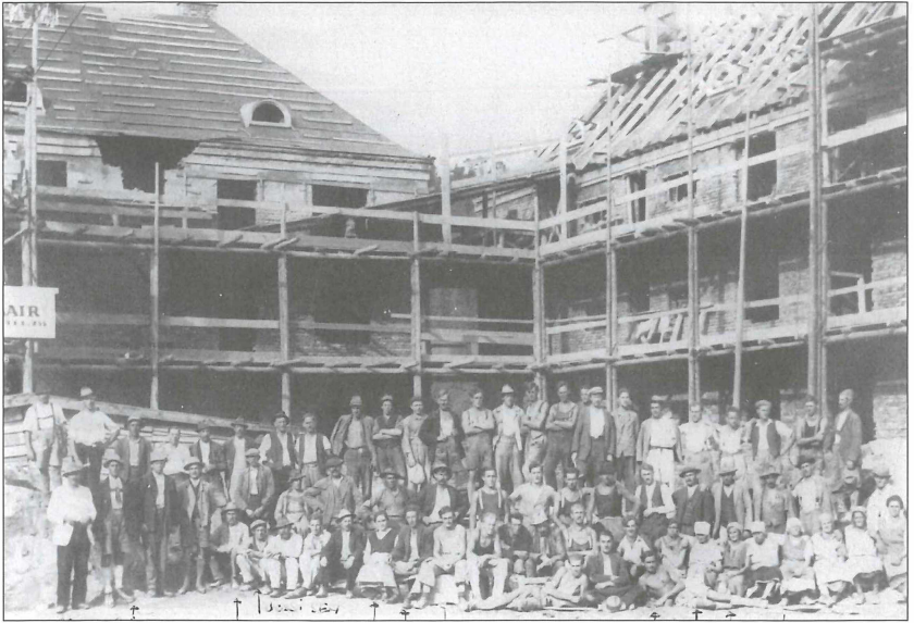
Abb. 12 Eine Baustelle Franzmairs in Bischofshofen, 1931 (Archiv Baumeister Hans Heuberger, Bad Hofgastein).
