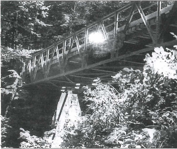
Alte Weißries Gitterträger Waldbahnbrücke, rechts zerstört vom Hochwasser 1966 (Fotos: Obfö. A. Engel).
