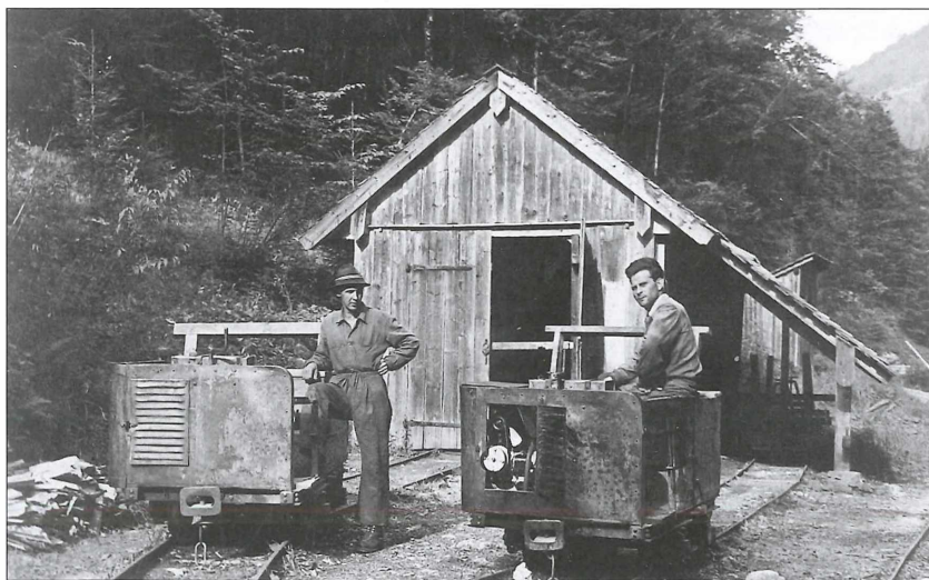
Zwei alte 4 PS Puch Benzin-Feldbahnloks vor der Remise am „Bahnhof“ Gaiseng (um 1935). Im Bild: links Franz Sams sen., der 1934 zu der Bundesforsten kam. Sams war Lokführer und konnte auch als gelernter Schmied anfallende Reparaturen in der Feldbahnschmiede durchführen (Foto: Franz Sams sen. Aufnahme mit Plattenkamera und Selbstauslöser).
