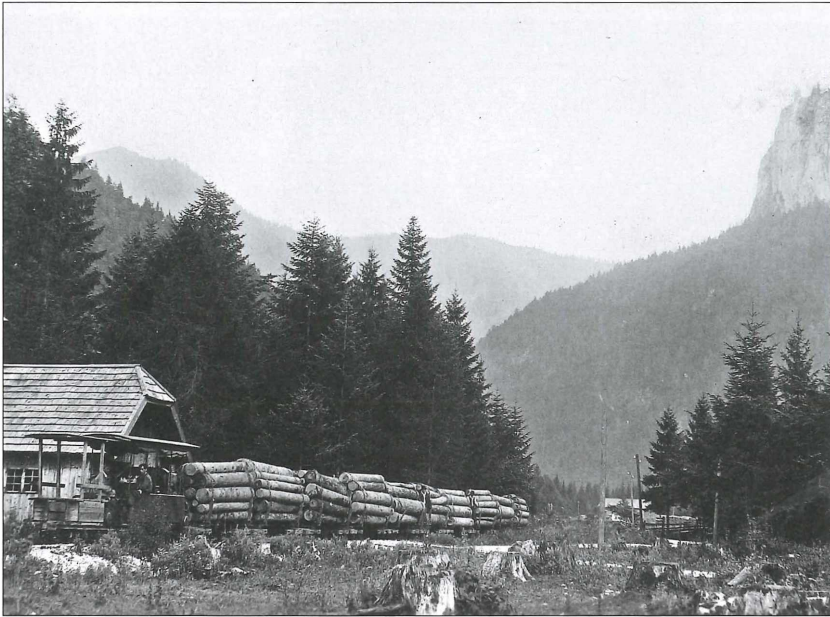
Waldbahnzug vor der Werkstatt beim Leitengraben.
