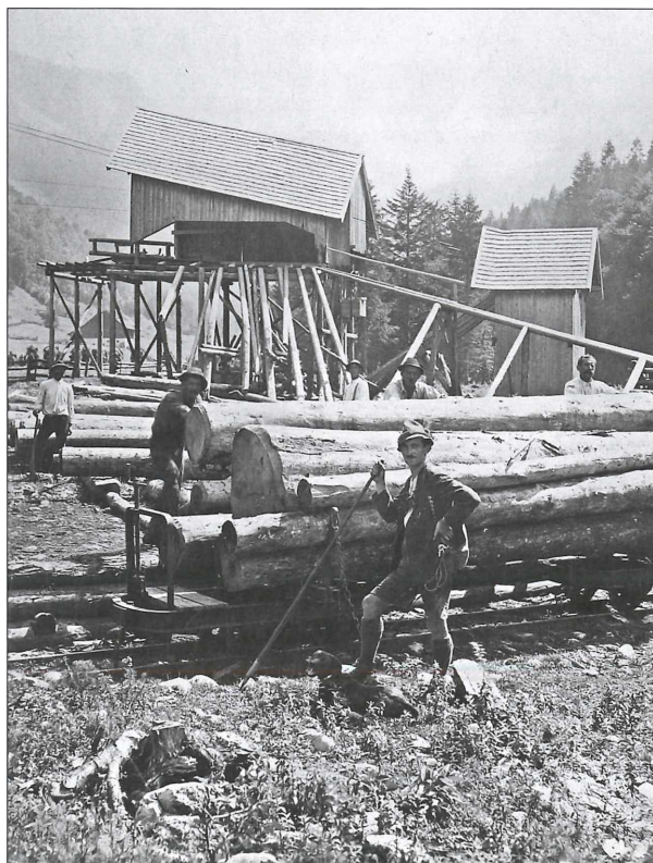
Talstation der Königsberg-Seilriese und Kopfstation der Wald- bahn in den Lämmerbach; die Wagen wurden mit 4 bis 4,5 fm Holz beladen. — Vorne: Obfö. Anton Haas sen.
