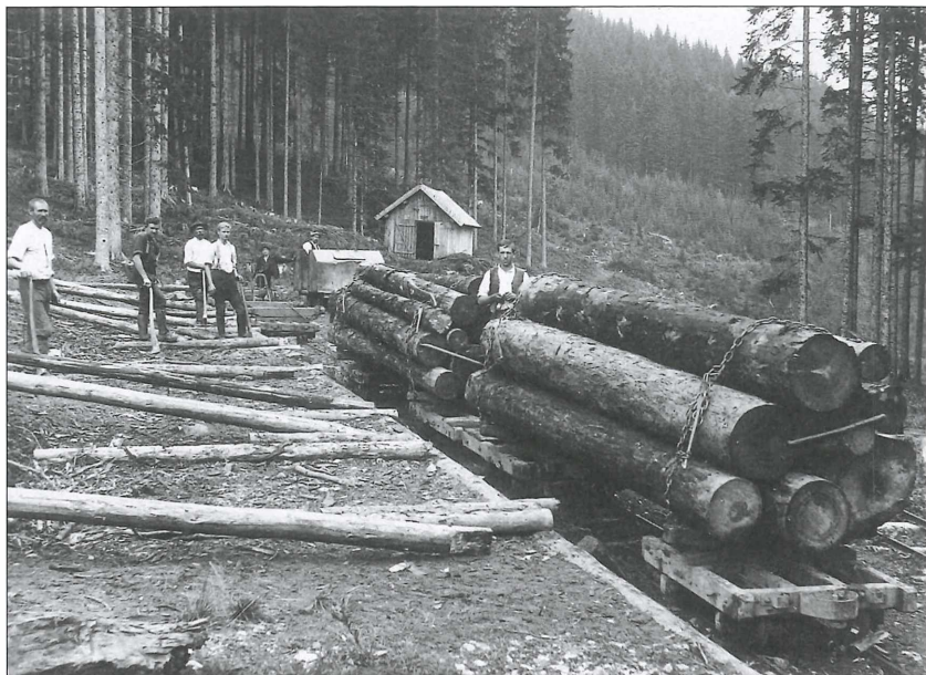
Zubringer Rollbahn aus dem Schafbachgebiet zur Bergstation der Schöberlboden-Seilriese. Hinten der 6 PS Daimler-Benzintriebswagen zur Rückbeförderung der Leerwagen.
