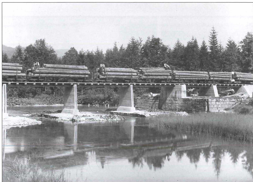
Vollbeladener Waldbahnzug auf der Brücke über den Brunnbach am Seeende. Mit 16 bis 18 Wagen pro Zug konnten 70 bis 80 Festmeter Holz transportiert werden, Fahrgeschwindigkeit rund 4 bis 12 km je Stunde, Jahresleistung 10.000 bis 14.000 fm.
