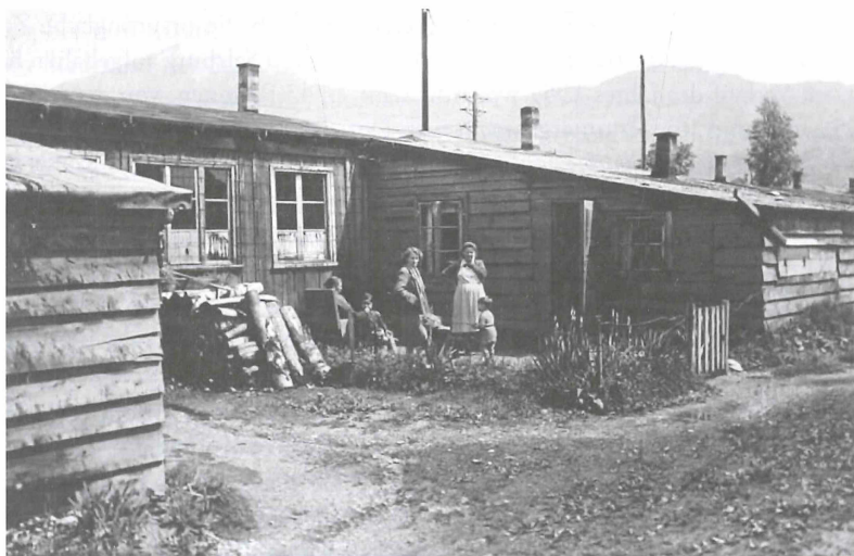
Abbildung 5: Die Baracke Nr. 40 in der Alpenstraße, Salzburg (1957), Quelle: AStS
