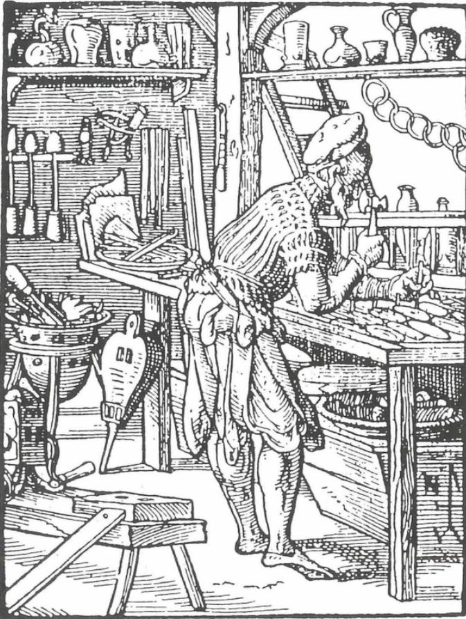
Abb. 3. Der Glaser nach Jost Amman, Frankfurt 1568, in seiner Werkstatt bei der Arbeit. Mit seinem Bleihammer setzt er gerade Bleinägeln zum Fixieren der Butzen.
