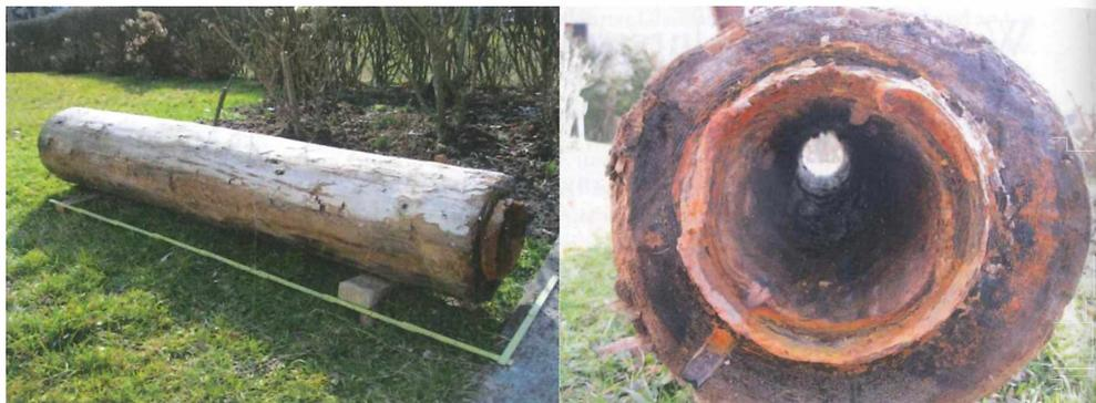
Abb. 2: Teuchel – Bauteillänge des Holzrohres ursprünglich rund 3 Meter, stirnseitig mit eingeschlagener Metalhülse<sup>4</sup> zur Herstellung einer dichten Verbindung mit der Anschlussröhre
