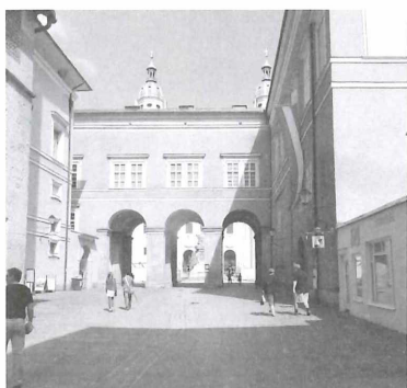
Abbildung 6: „Hofbogengebäude“, Westfront (Foto: Verfasser)
