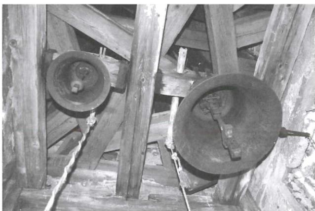
Abbildung 17: Beide Glocken im Turm der Georgskirche werden von Hand geläutet, nur die größere dient als Schlagglocke für die Turmuhr. Im Bild ist oberhalb des Glockenstuhls der neue Dachstuhl des Turmhelms zu sehen, der 2004 kurz vor dem Abschluss der Renovierung der Zellhofkirche aufgesetzt wurde.<sup>15</sup> (Foto: Neureiter)
