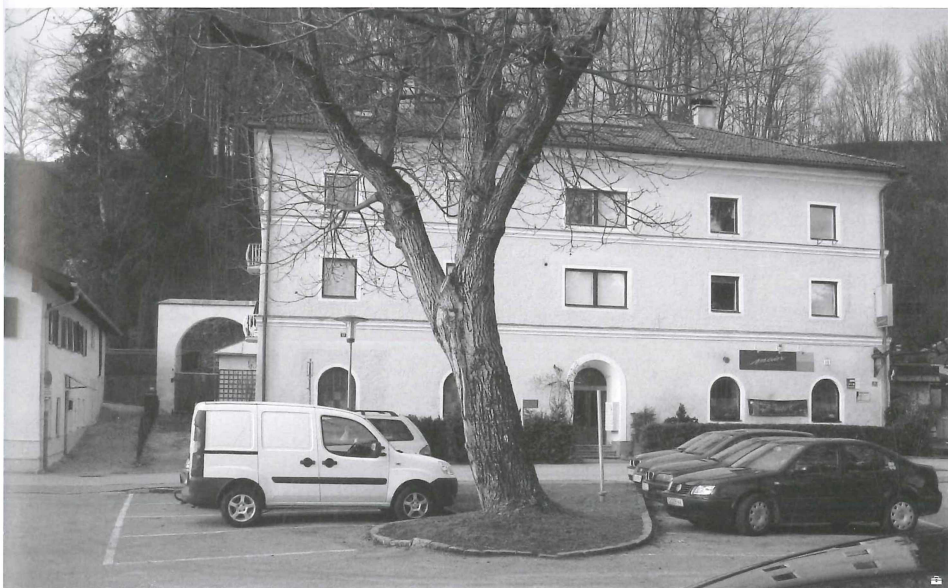
Abbildung 6: Pferde- und Viehstallungen des Schifferspitals heute mit neuen Fenstern, Walmdach und mit zwei Kaminen
