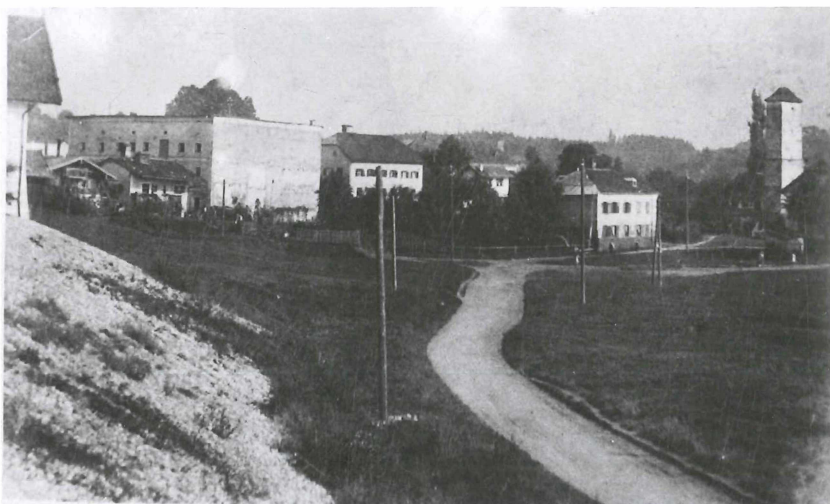
Abbildung 4: Das Heiligen Geist-Spital (Schifferspital) vor 1919. Der zur Salzach hin gelegene Trakt nach Hochwässern bereits abgebrochen. Anschließend der alte Pfarrhof und ganz rechts der Wasserturm.
