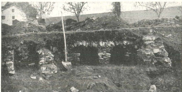
Abb. 1. Gewölbehypokaustum des Hauses A.
