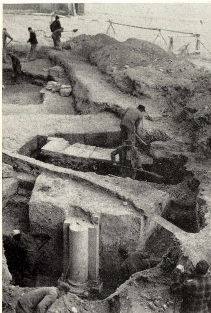
Abb. 13 Blick auf den ersten Suchgraben mit Krypta und Querhaus
