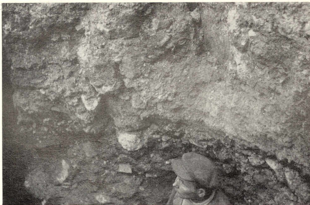
Abb. 6 Fundament der Querhausmitte
