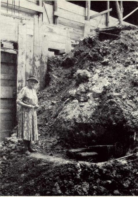
Abb. 3 Römische Holzwasserleitung (doppelt) in situ; der links fehlende Teil vom Bagger entfernt, nach rechts noch Fortsetzung. Rückwand mit Schalung entspricht der linksseitigen Häuserfront der Linzer Gasse.
