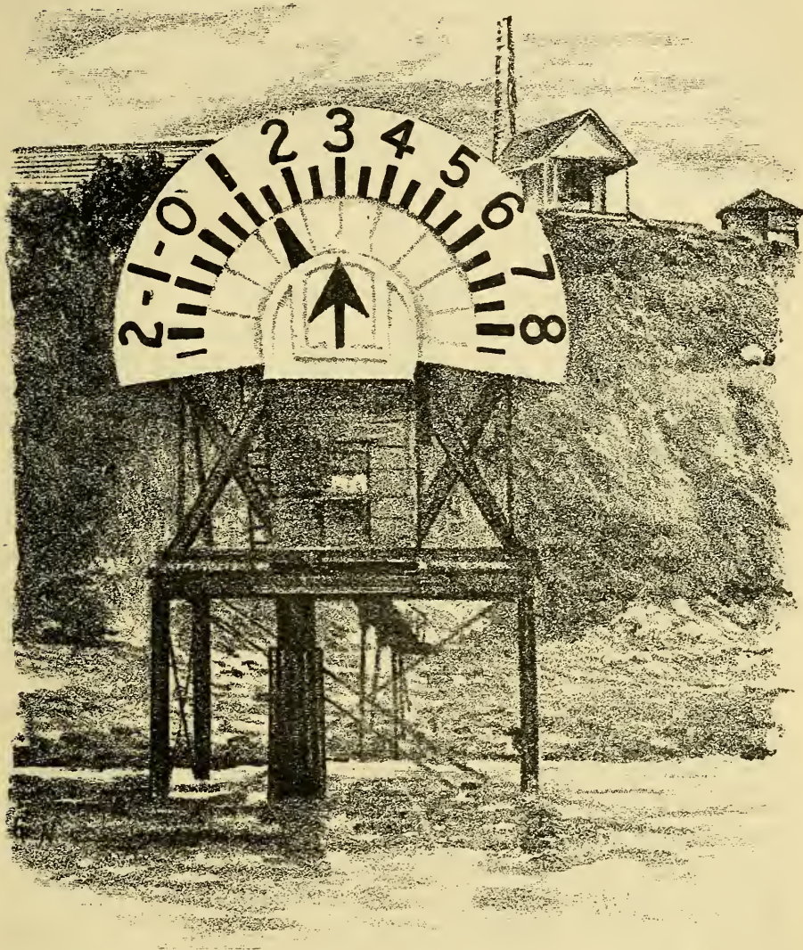
Automatischer Flutzeiger bei San Francisco.
