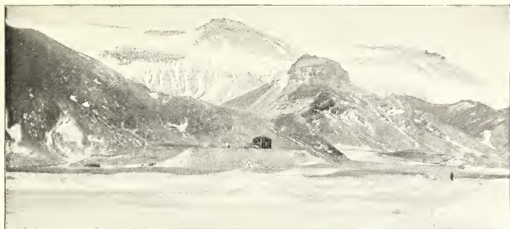
Die Snow-Hill-Station von Norden gesehen. »A«: Anemometerplatz.
