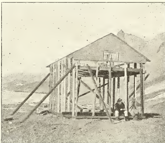
Fig. 3. Das Grundgerüst unseres Wohnhauses.
