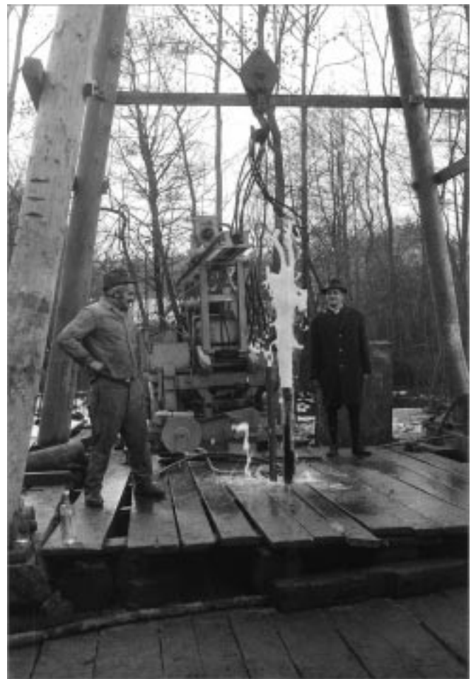
Abbildung 46. Thermalquellenerschließung in Bad Tatzmannsdorf (1973).
