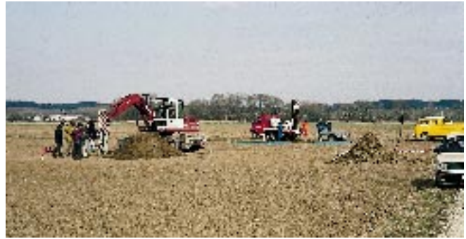
Abbildung 45. Künettenbaggerung und Tracernachweis im unteren Pinkatal nördlich Deutsch Schützen (Brunnenfeld Eisenberg).
