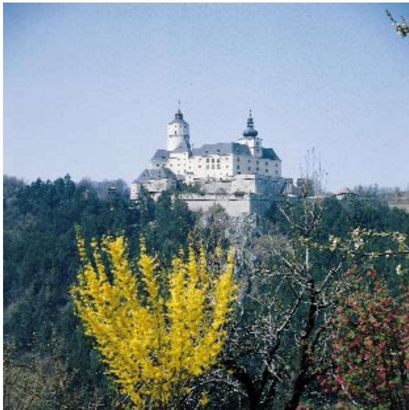
Abbildung 25. Burg Forchtenstein mit ihrer Unterlage aus zentralalpiner karbonatischer Trias, die die Grenze zwischen Wechsel- und Grobneiseinheit markiert.
