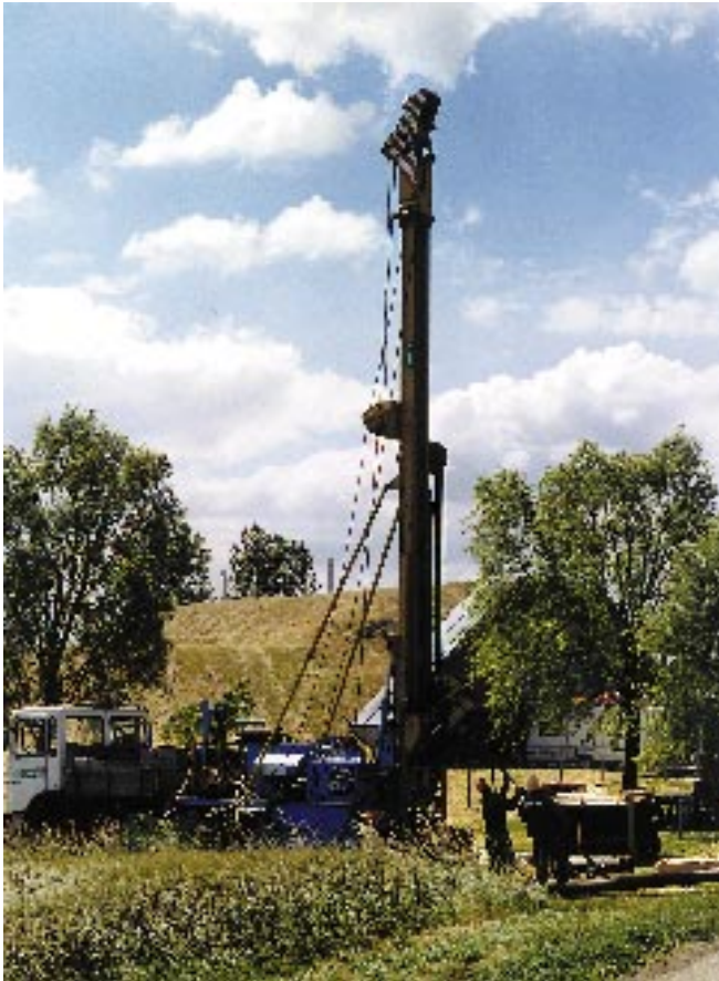
Abbildung 44. Messstellenbohrung Purbach (Juli 1999).
