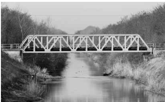
234. ábra. Vasúti híd Mosonmagyaróvár és Csorna között (fotó: R. Triebel)
