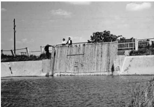
22. ábra. Mekszikópuszt. Régi tűsgát (Fotó: ÉDUKÖVIZIG)
