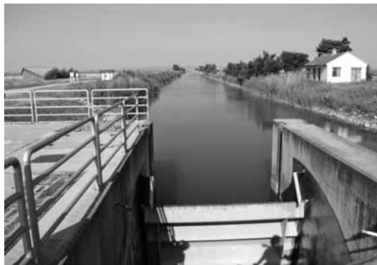
23. ábra. Mekszikópuszt. Billenőtáblás gát (Fotó: ÉDUKÖVIZIG)
