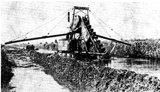
32. ábra. A „Mariska” kotró a Hanság-csatornán (Fotó: ÉDUVIZIG)
