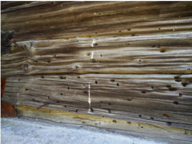
**Abbildung 34: Holzbalken mit Bohrlöchern im Detail**
