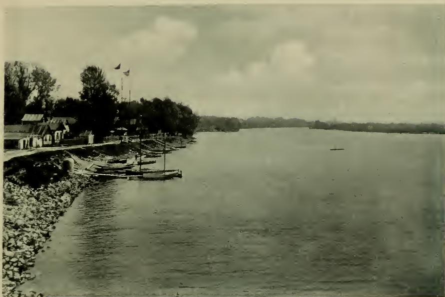
Brückenwasser, von der Kagrauer Strasse aus gesehen.
